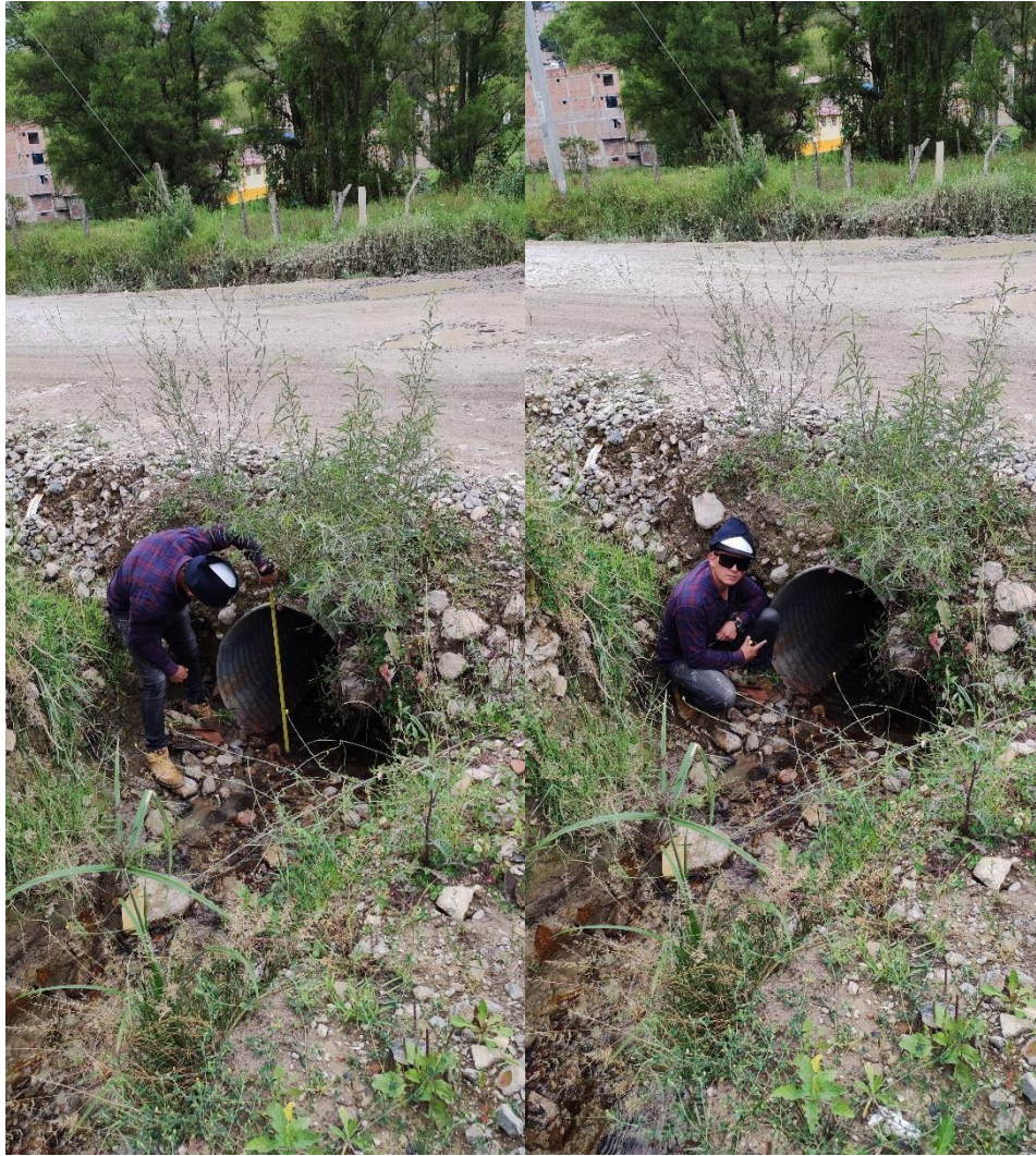
Ubicación de segunda Alcantarilla entre las progresivas 00+360.00 - 00+380.00 estado actual bueno, y que cumple con su función acorde, mínimo material sedimentado.
