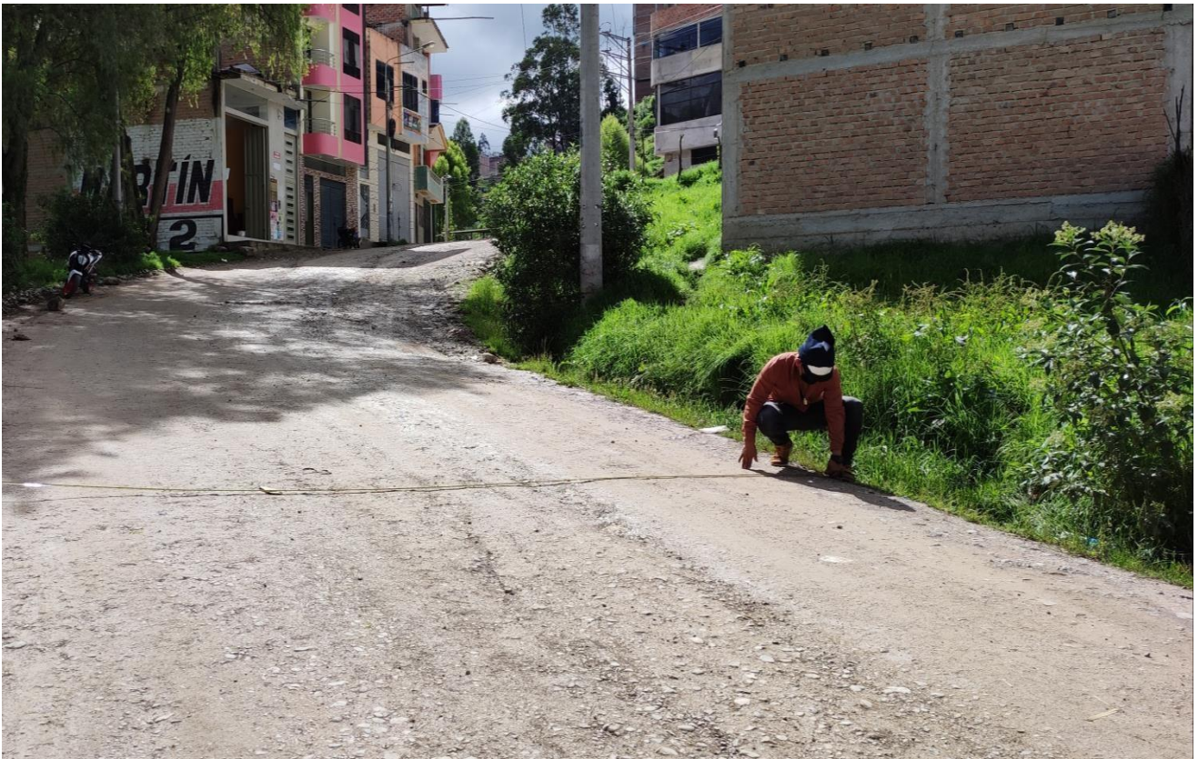
Progresiva 02+000.00 medición de ancho de vía disponible para diseñar
