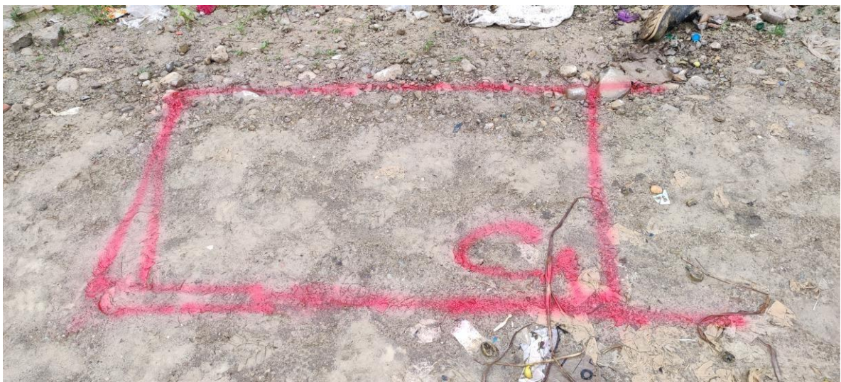
Calicata N°1 C-1 Ubicada en la progresiva 00+340.00 borde lateral derecho
