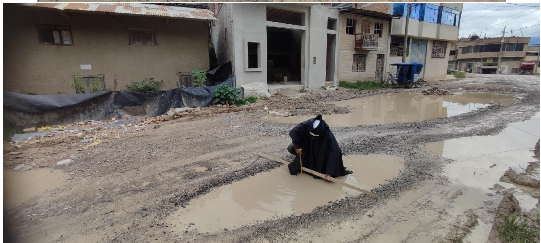
Identificación de baches, encalamiento y lodazal
