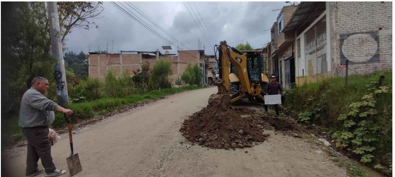
Calicata N°3 C-3 Ubicada en la progresiva 01+480.00 borde lateral derecho
