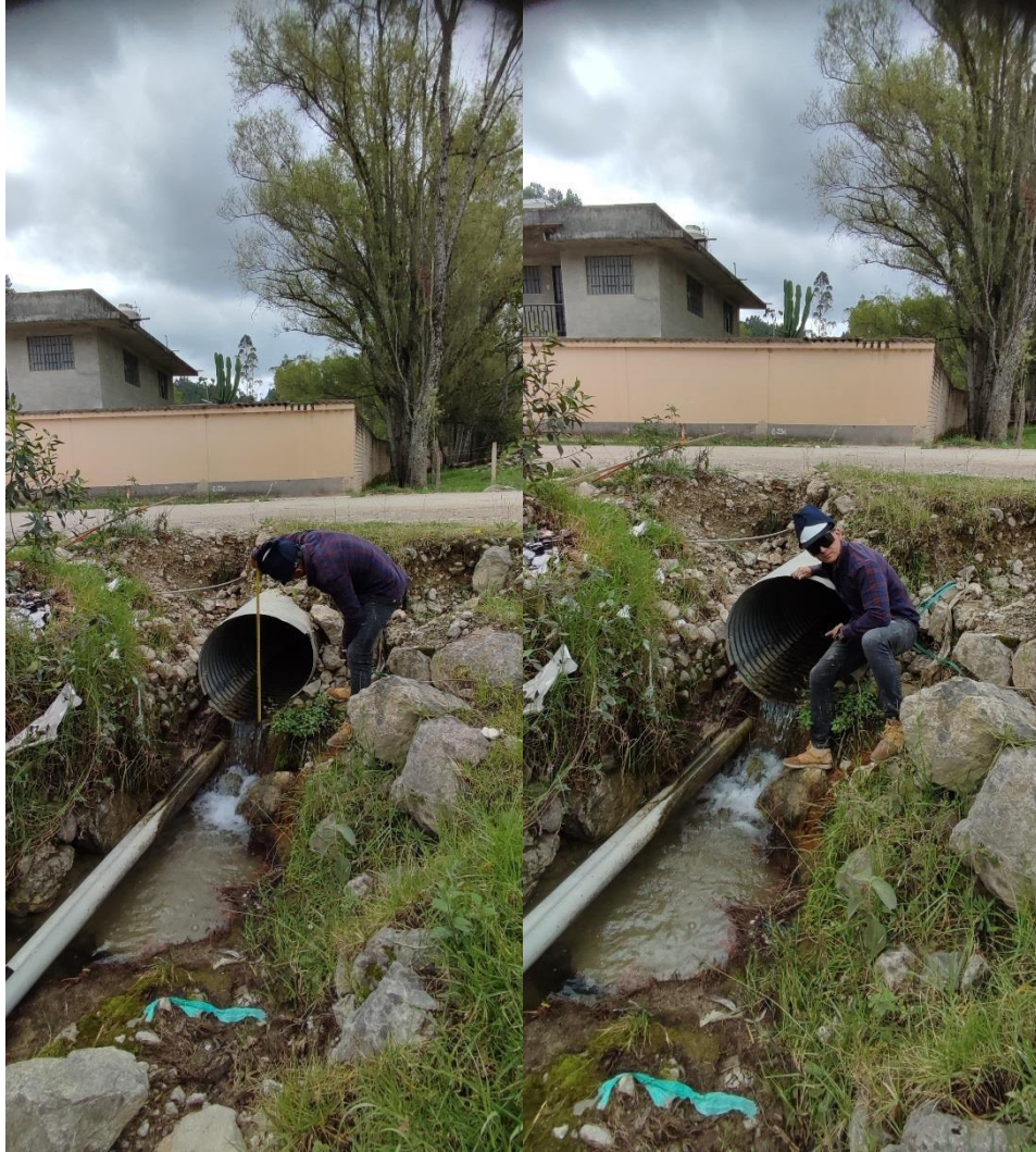
Ubicación de primer Alcantarilla progresiva 00+700.00, estado actual bueno, y que cumple con su función acorde
