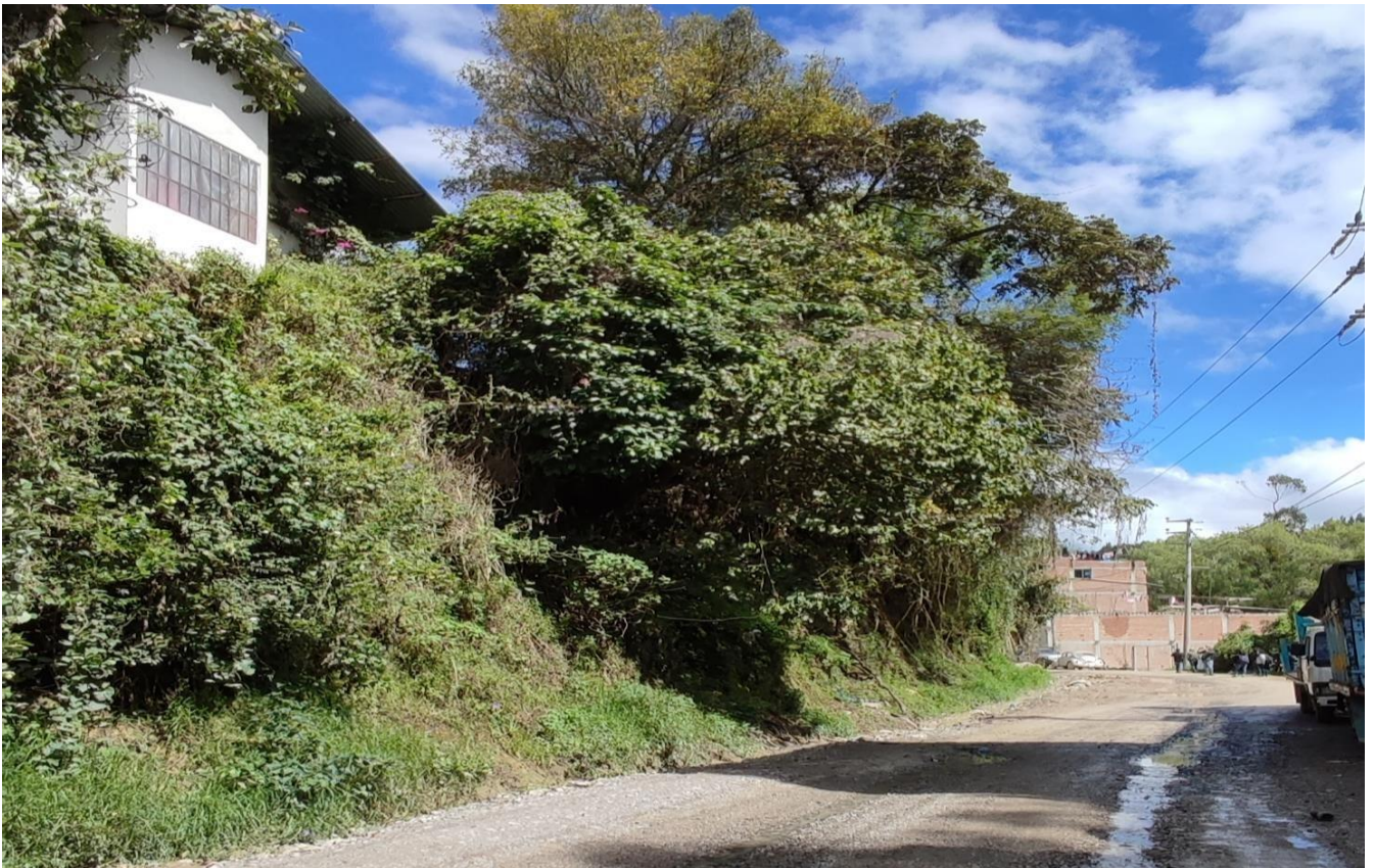
Progresiva 01+650.00 se aprecia la ladera, mencionada y todo su desarrollo
