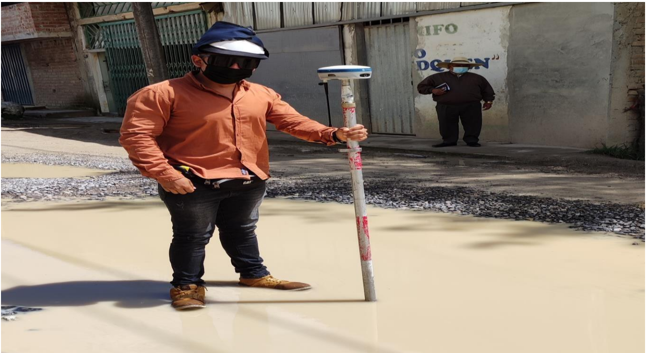
Progresiva 01+800.00 lodazal de 10cm en este tramo de la vía, producto de las precipitaciones y no presencia de sistema de drenaje para evacuar las aguas
