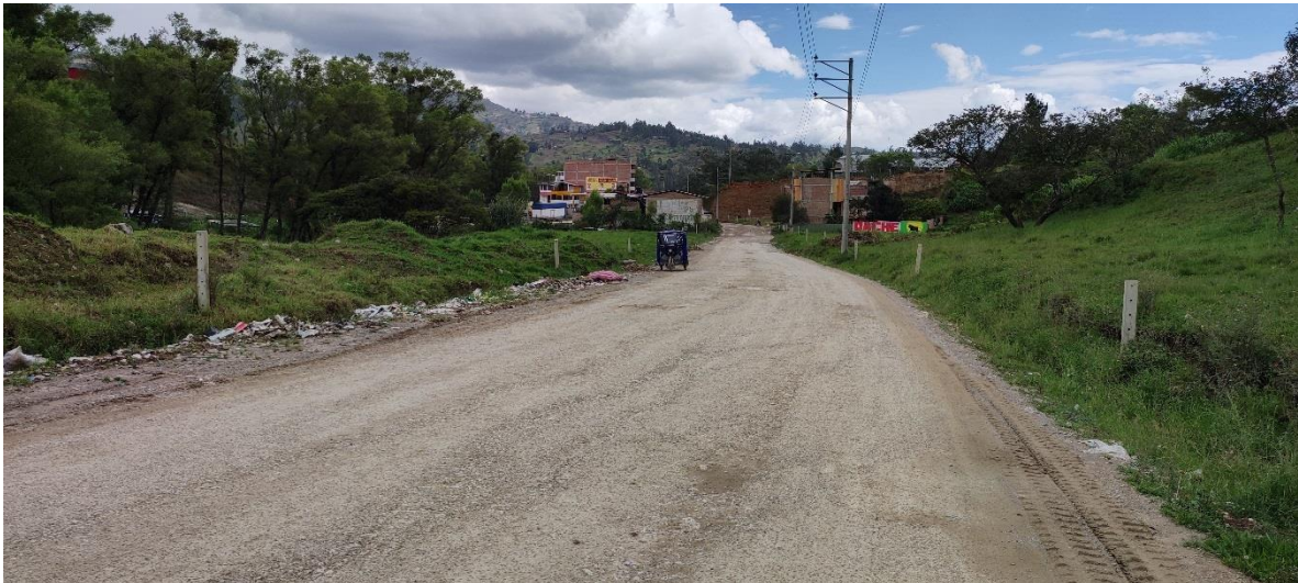
Estado de vía en buenas condiciones, ancho útil despejado, presencia de cunetas en todo su largo.
