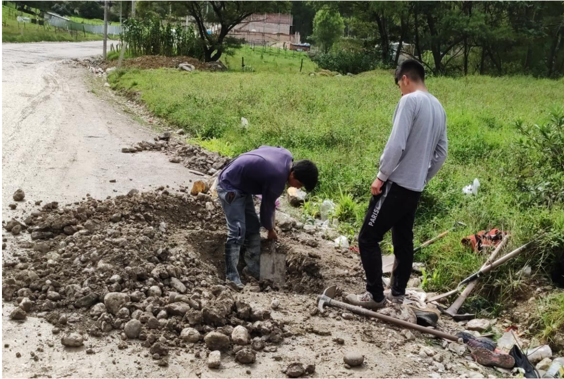
Brigada trabajando de forma manual hasta llegada de maquinaria
