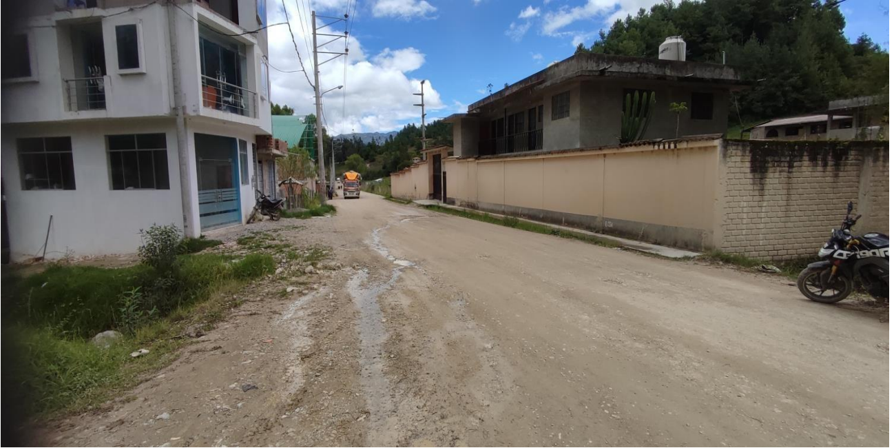
Progresiva 00+800.00 se aprecia la presencia de agua, consecuencia de las precipitaciones constantes hasta la fecha.
