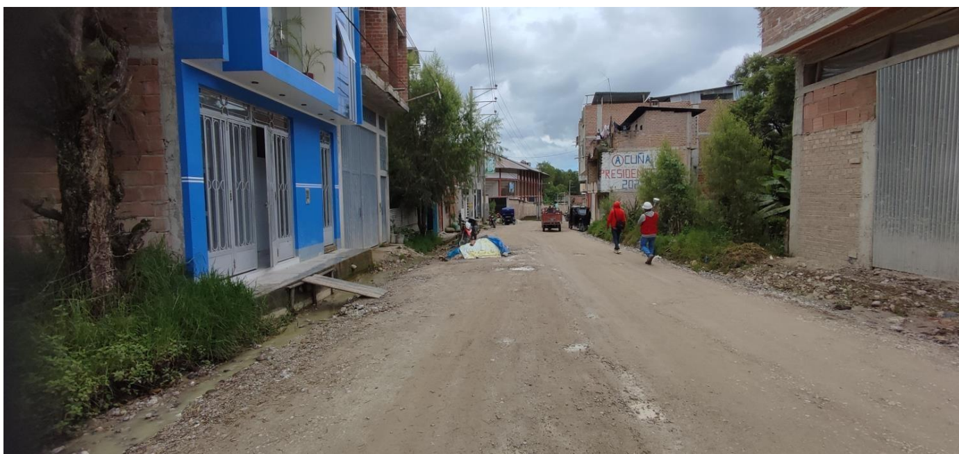
Progresiva 01+200.00 se aprecia la vía es buen estado, con pequeños baches y material de construcción dejado por vecinos
