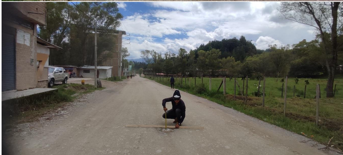
Estado de vía en buenas condiciones, ancho útil despejado, y no presencia de cunetas en todo su largo.
