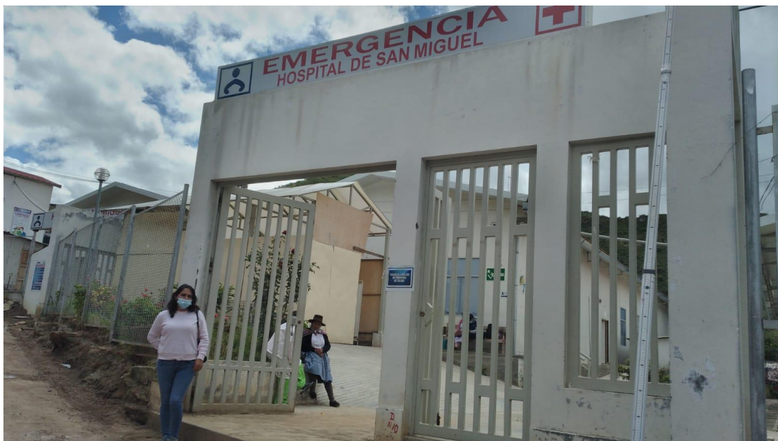
Fotografía N°01: Trabajo de campo Hospital de Apoyo San Miguel – La Mar.
