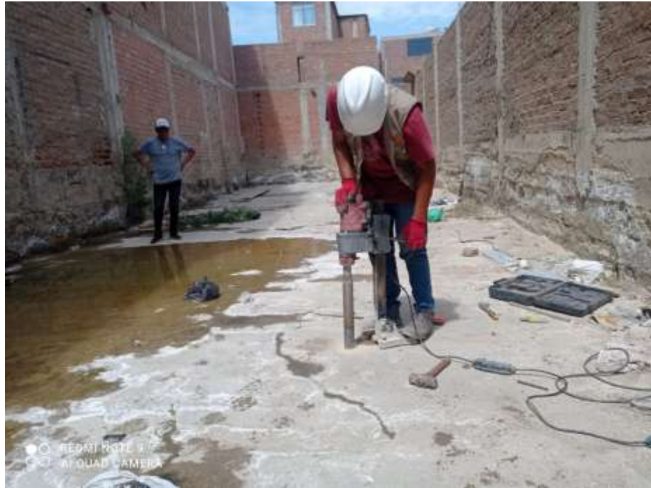
FOTOGRAFIA 03: Se Muestra La Extracción De El Núcleo De Diamantina (D2), de la platea para la tesis: “Diseño estructural del Edificio Administrativo del Colegio de Biólogos con disipadores de energía para el control de asentamientos, Lambayeque 2022”
