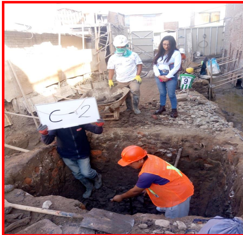
Foto 4. Ubicación y apertura de calicata C-2.
