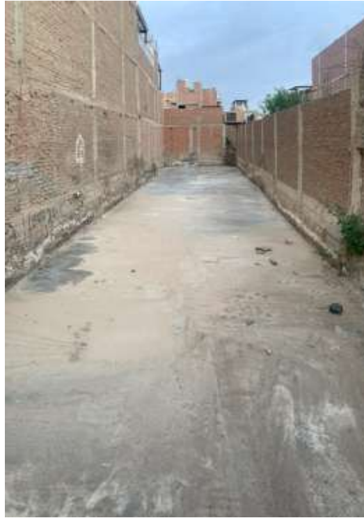
FOTOGRAFIA 01: Vista panorámica del de la platea para la tesis: “Diseño estructural del Edificio Administrativo del Colegio de Biólogos con disipadores de energía para el control de asentamientos, Lambayeque 2022”
