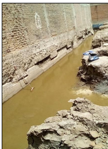
Figura N ° 02 Tipo de suelo y napa freática
