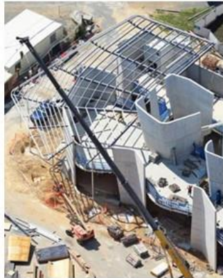
Imagen 16. Estructura de cubierta. Fuente: arquitectonica.com
