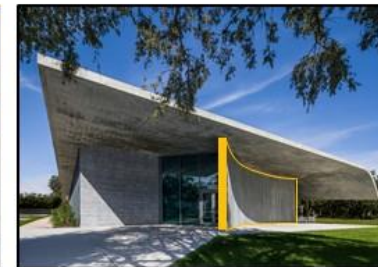
Imagen 18. Muro estructural del acceso. Fuente. arquitectonica.com
