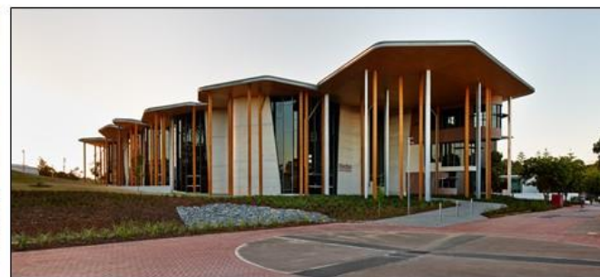
Imagen 2. Fachada lateral. Fuente. https://www.archdaily.pe
