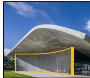
Imagen 17. Muro estructural lateral. Fuente. arquitectonica.com
