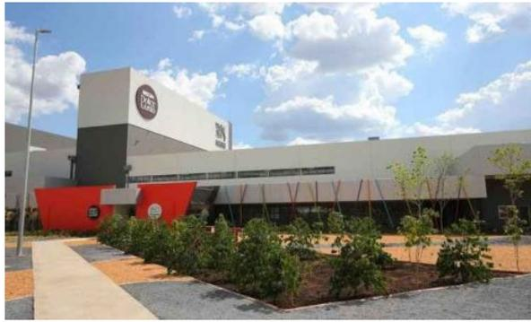
La fábrica de café liofilizado está localizada en Colombia en el municipio de Chinchiná, siendo un eje central cafetero colombiano. Tiene un área de 6,000 m<sup>2</sup> se plantea una estructura metálica antisísmica con cerramientos en vidrio y lámina de aluminio e cual ha sido perforada para permitir una alta ventilación por convección debido al calor producido por la fábrica.
