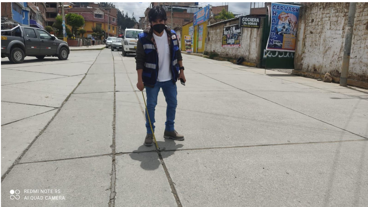
Fotografía 04, se puede apreciar el Parcheo Grande producido por la instalación del servicio de gas domiciliaria, esto es en la totalidad de la Avenida Manco Cápac.
