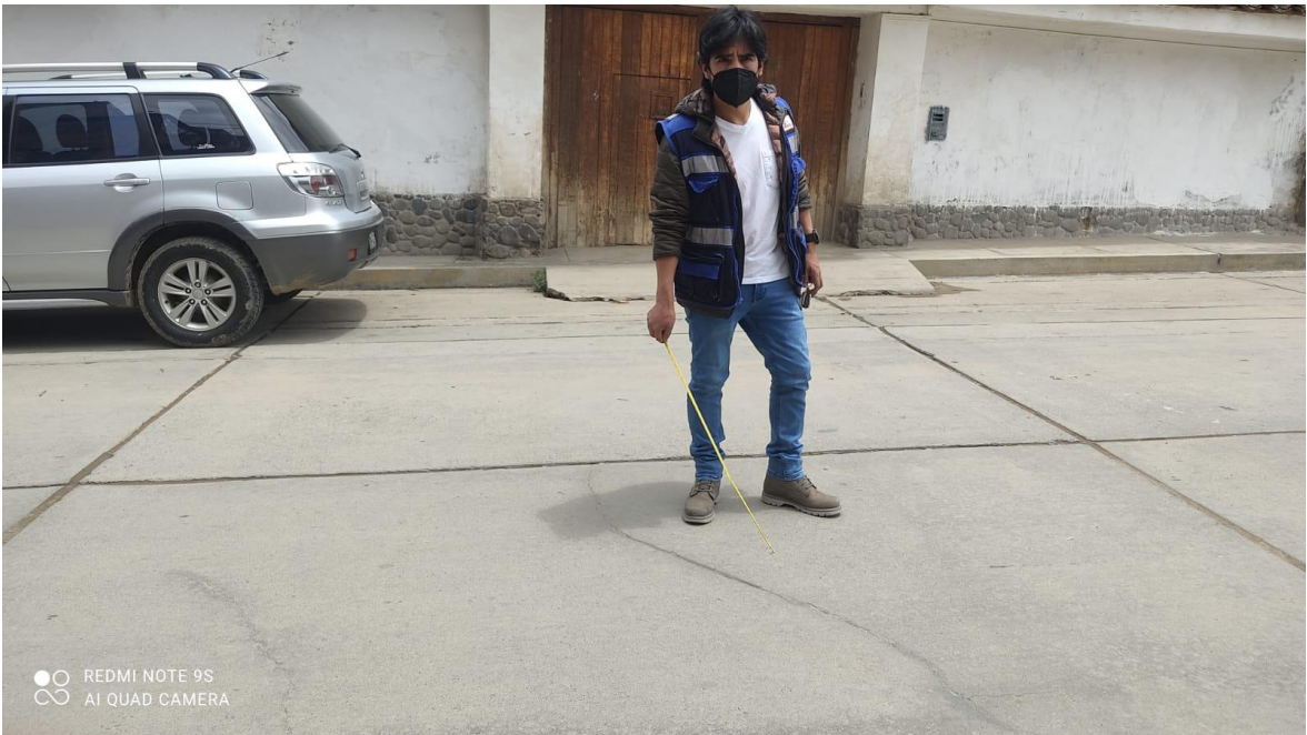
fotografía 10, se aprecia la falla de Grieta de Retracción de una intensidad alta
