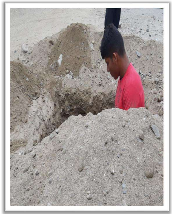
Figura N°12: CALICATA EN KM 5+500, Remarcado, Excavación.
