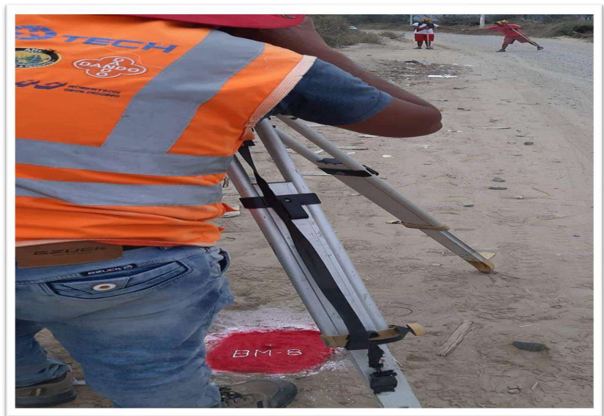
Figura N°08: BM-08, NORTE: 9345148.28, ESTE: 633145.746, ELEVACIÓN: 129.734. Fuente: Elaborado por el investigador.
