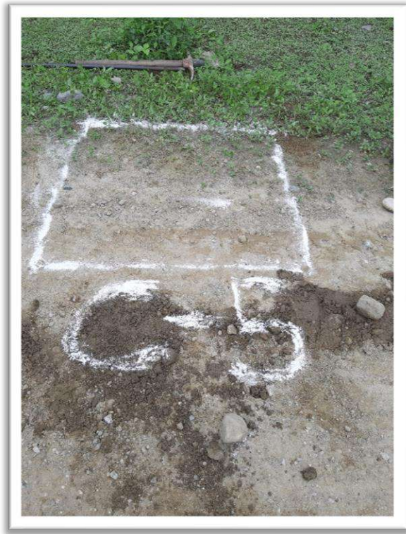
Figura N°05: CALICATA EN KM 2+000, Remarcado, Excavación y medición.
