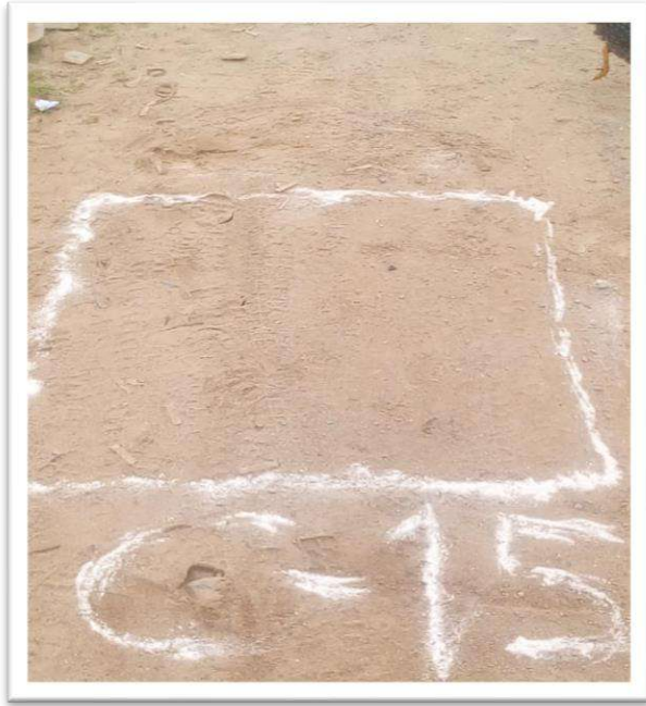
Figura N°15: CALICATA EN KM 7+000, Remarcado, Excavación y medición.
