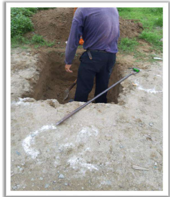
Figura N°02: CALICATA EN KM 0+500, Remarcado y Excavación.
