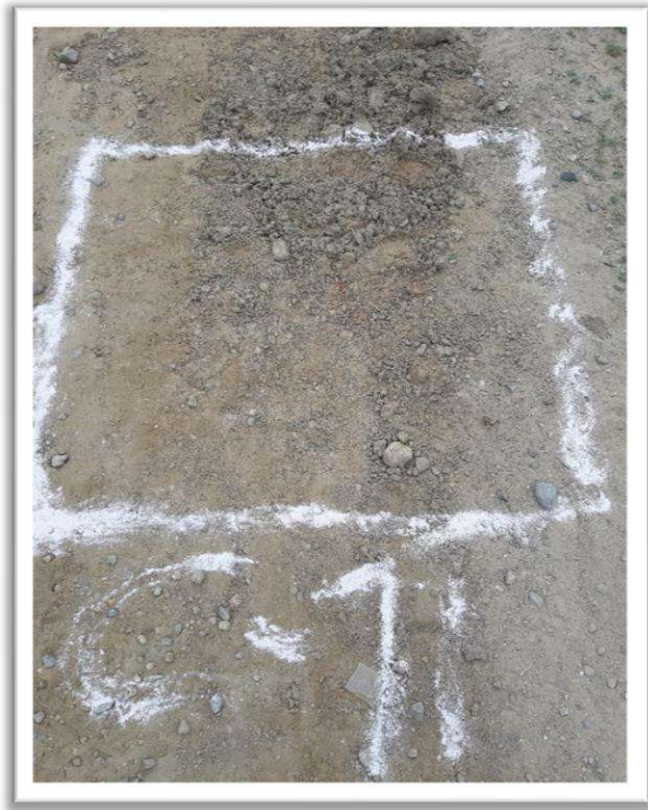
Figura N°11: CALICATA EN KM 5+000, Remarcado, Excavación y extracción de sustratos por capas.
