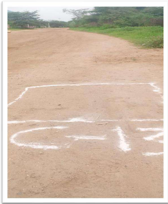
Figura N°13: CALICATA EN KM 6+000, Remarcado, Excavación a 0.30 cm del cascajo.
