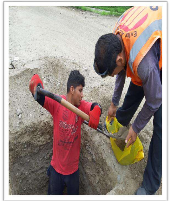
Figura N°09: CALICATA EN KM 4+000, Remarcado y Extracción del sustrato
