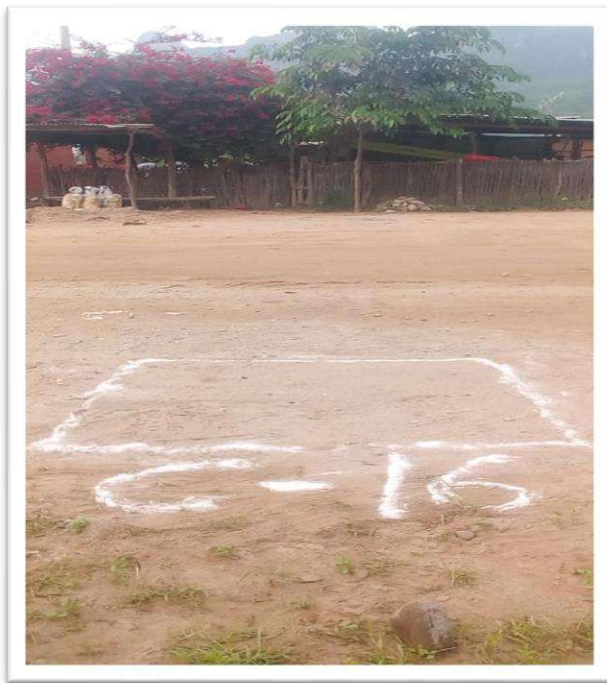
Figura N°16: CALICATA EN KM 7+500, Remarcado y medición de 1.50 m.
