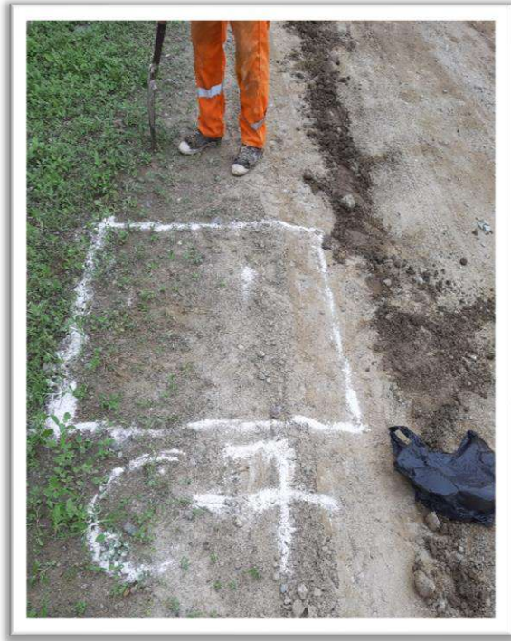
Figura N°07: CALICATA EN KM 3+000, Remarcado y Extracción del sustrato
