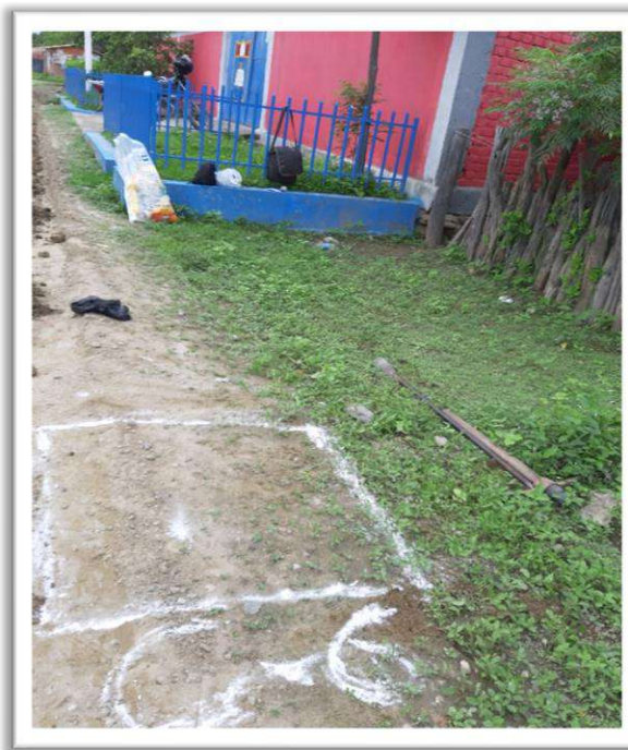
Figura N°06: CALICATA EN KM 2+500, Remarcado y Excavación.
