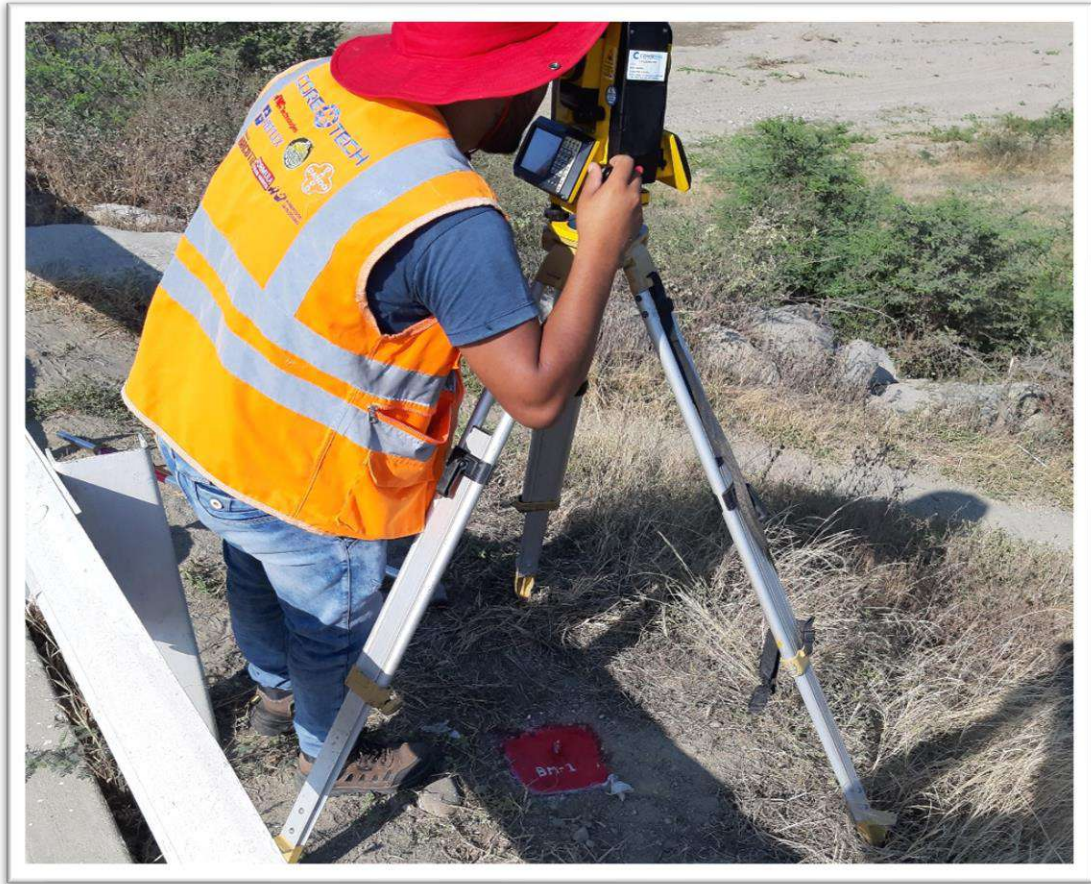
Figura N°01: BM-01, NORTE: 9344310.92, ESTE: 637036.72, ELEVACIÓN: 149.23.
