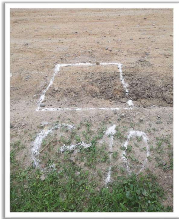
Figura N°10: CALICATA EN KM 4+500, Remarcado, Excavación y medición.
