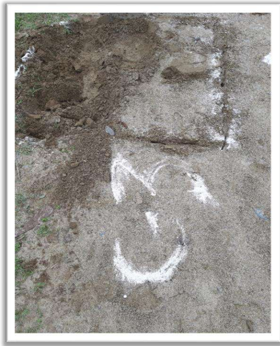
Figura N°03: CALICATA EN KM 1+000, Remarcado y Excavación.
