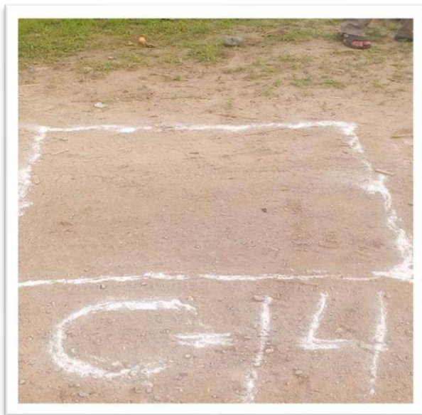
Figura N°14: CALICATA EN KM 6+500, Remarcado, Excavación.
