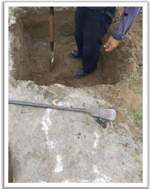
Figura N°01: CALICATA EN KM 0+00, Remarcado y Excavación.
