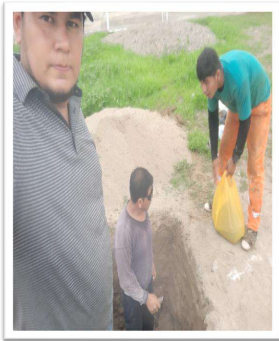
Figura N°17: CALICATA EN KM 8+000, Remarcado, Excavación y extracción de sustratos por capas.
