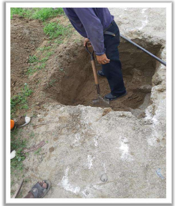
Figura N°03: CALICATA EN KM 1+000, Remarcado y Excavación.
