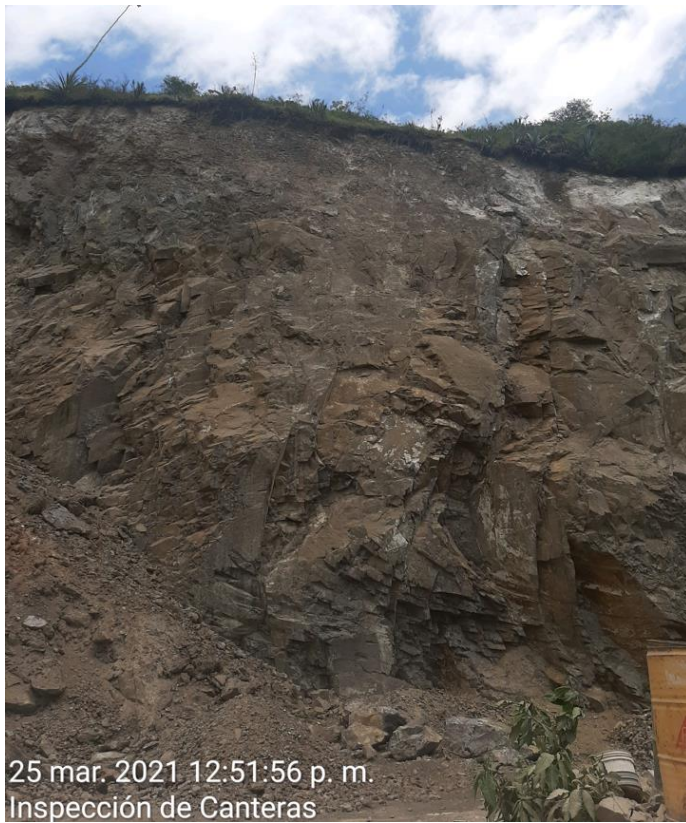
Figura 26. Toma frontal 2 de la cantera.
