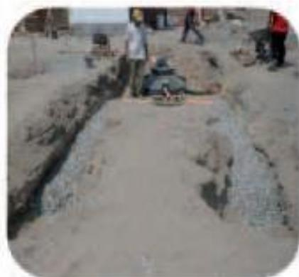
Horizontal tipo zanjas de infiltración.
