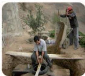
Para estabilizar el biodigestor se debe confinar solo parte cónica con arena o con terreno natural cernido.
