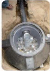
Los aros plásticos deben agregarse cuidando que no vayan a ingresar por la tubería de 4", ni obstruir las otras salidas.
