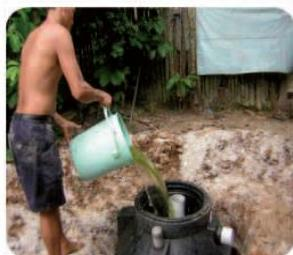
OBLIGATORIAMENTE ANTES DE COLOCAR EL RELLENO alrededor del BIODIGESTOR debe llenarlo con agua, de preferencia no potable, libre de sólidos. Esto para que las fuerzas laterales del terreno no lo vayan a deformar.
