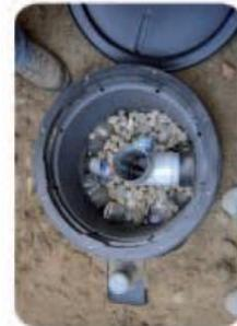
Al colocar los aros plásticos (PETS), agregue también una capa de piedras, de preferencia planas de poco espesor y completamente limpias, esto para mantener estables los aros y así se evitará que los PETS sean arrastrados por la tubería de salida (2"), y la vayan a obstruir.
