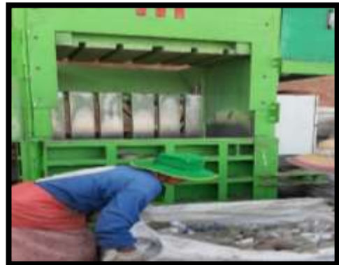
Figura 28 transporte al área de prensado
