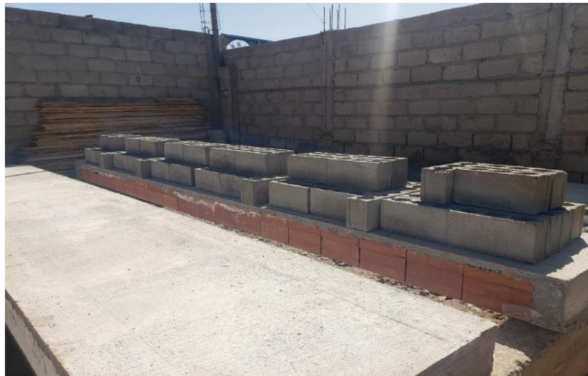
Figura 14. Aplicación de carga muerta a las losas aligeradas convencionales.
