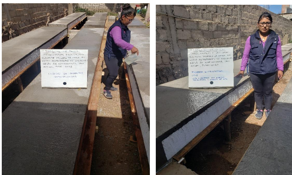
Figura 9. Curado de las losas aligeradas de concreto.
