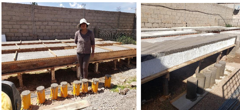
Figura 8. Toma de muestras del concreto.
