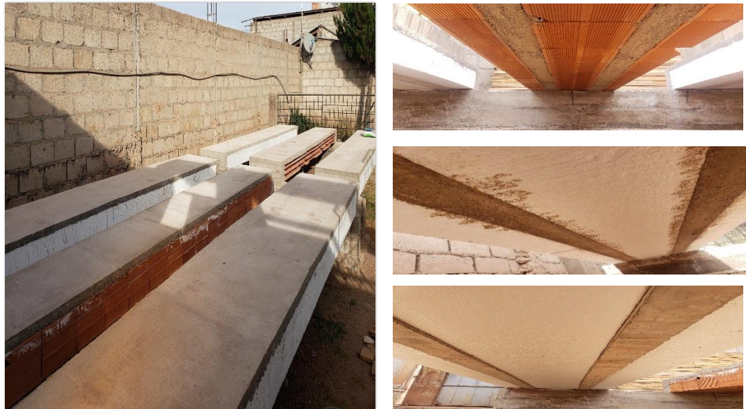
Figura 10. Desencofrado de las losas aligeradas de concreto.
