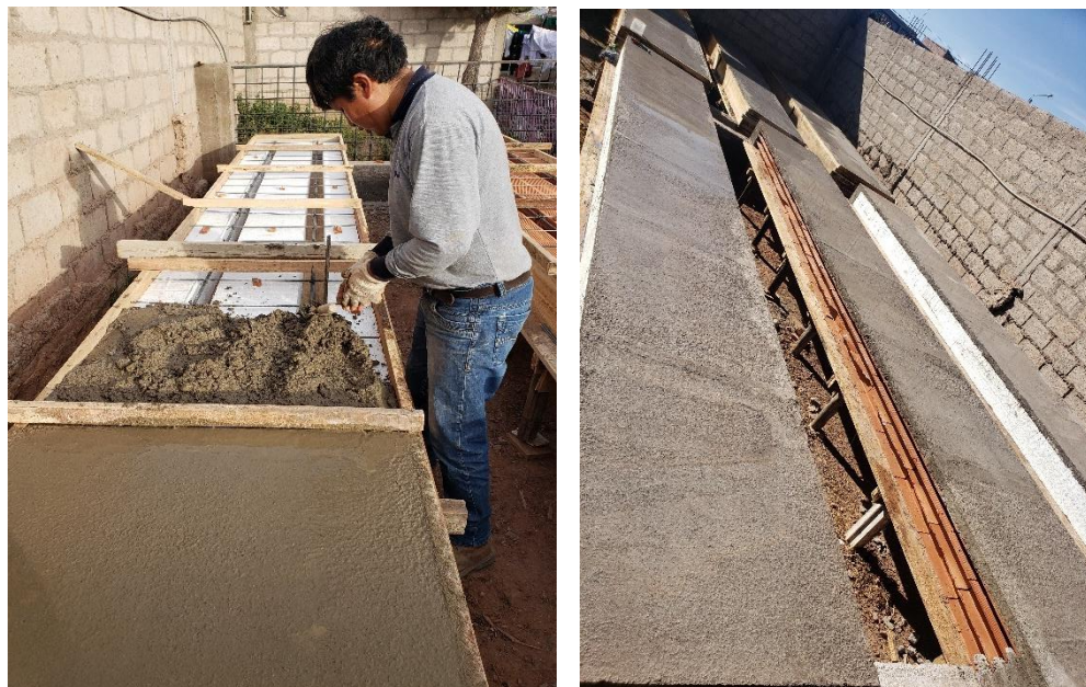
Figura 7. Colocado del concreto para las 6 losas aligeradas.
