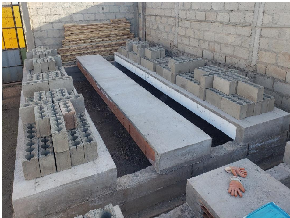
Figura 16. Aplicación de carga muerta a las losas aligeradas con viguetas pretensadas y bloques de EPS.
