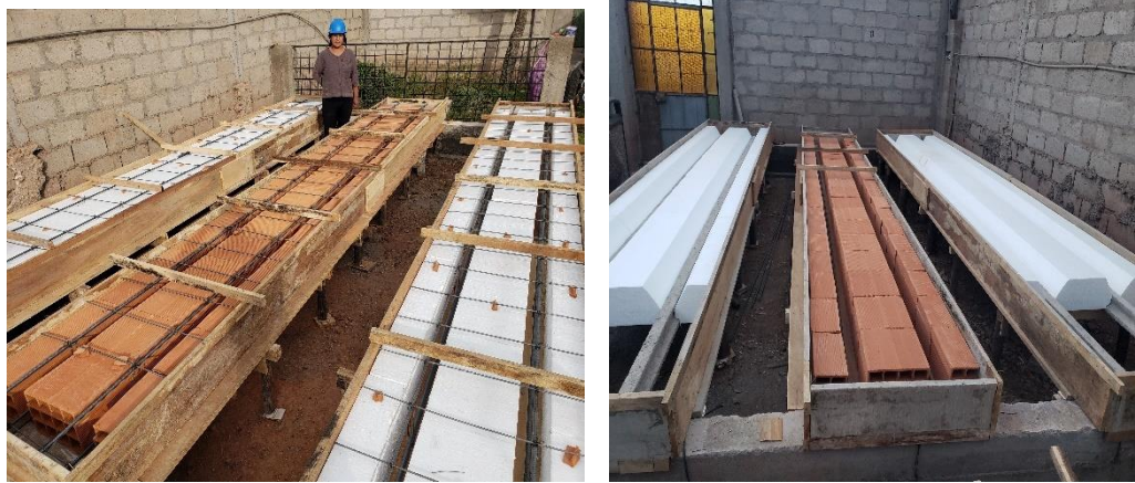
Figura 6. Vista del armado de las losas aligeradas.
