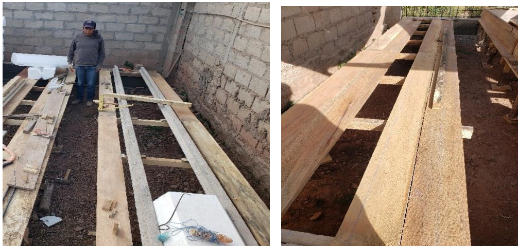
Figura 5. Elaboración del encofrado para las losas aligeradas.
