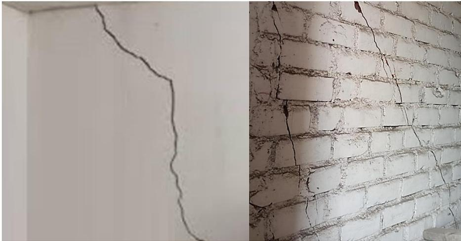
Figura 2: Daños en vivienda de albañilería confinada
