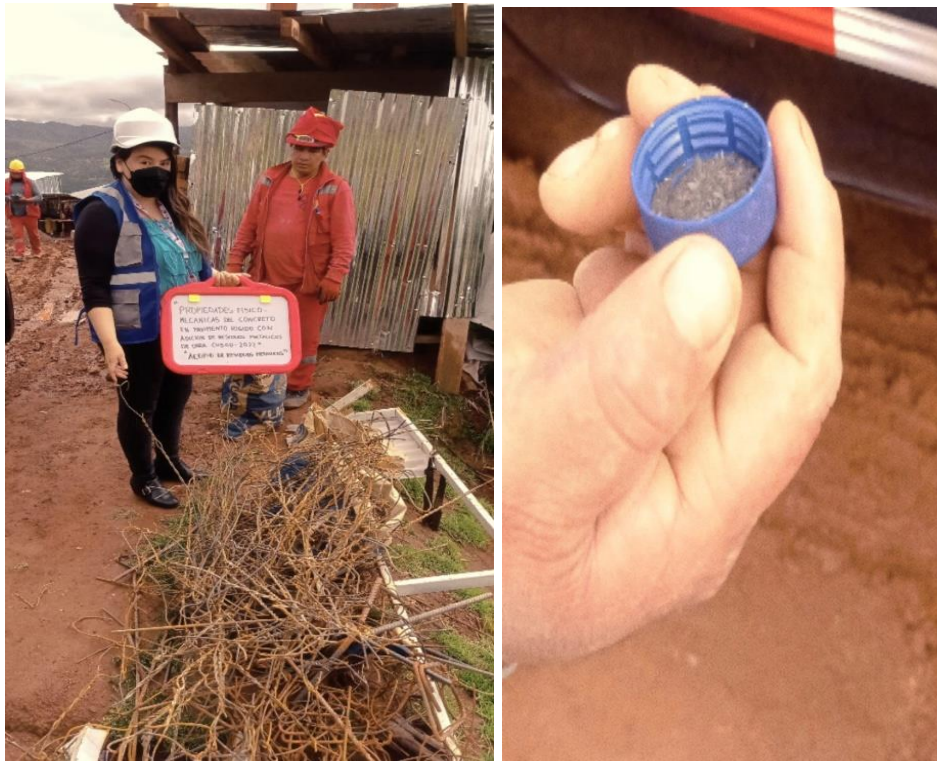
Figura 15. Acopio de RMO (Alambre # 16, #8 y limaduras de hierro) Fuente: Bonet Maldonado, 2022
