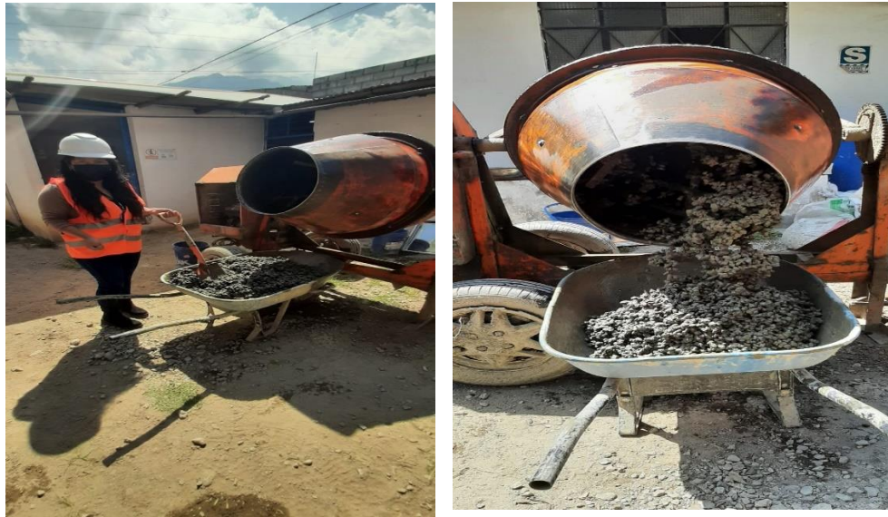
Figura 11. Elaboración de la pasta en la mezcladora
