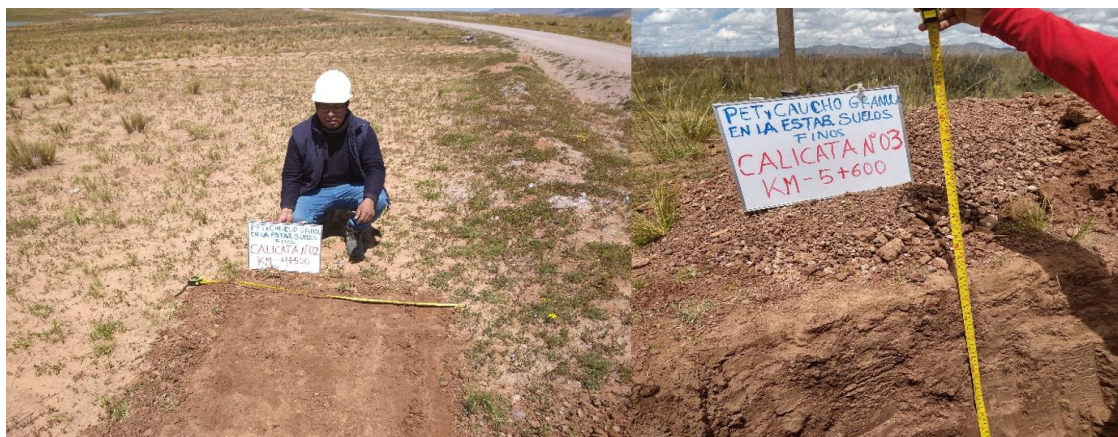
Figura 9. Reconocimiento y Excavación de Calicata N°03.
