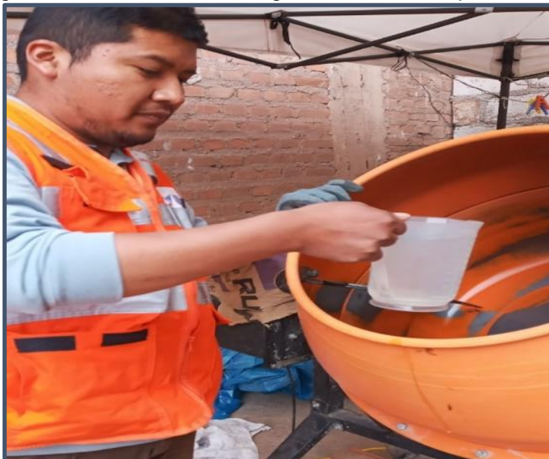
Imagen N° 35 Dosificación de agua en litros a trompo mezclador.
