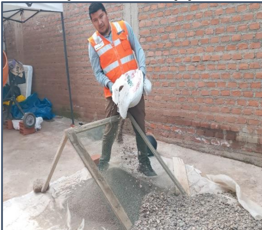
Imagen N° 29 Zarandeo de agregados.
