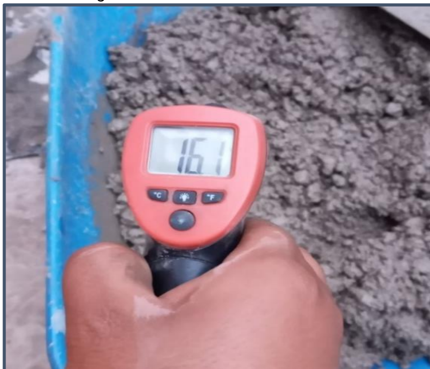
Imagen N° 37 Lectura del concreto fresco
