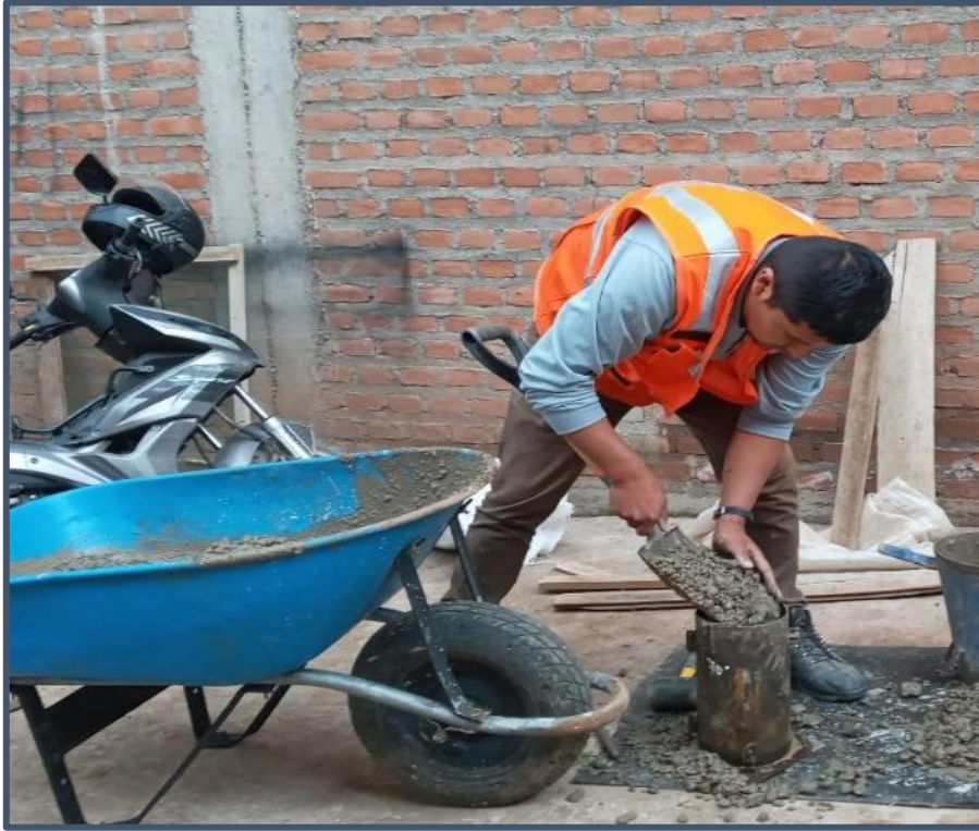
Imagen N° 42 Llenado de moldes con concreto.
