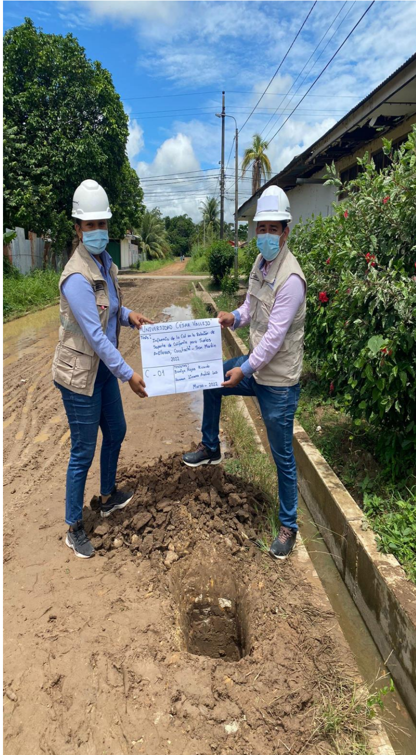
VISTA FOTOGRAFICA DE LA CALICATA N° 1
