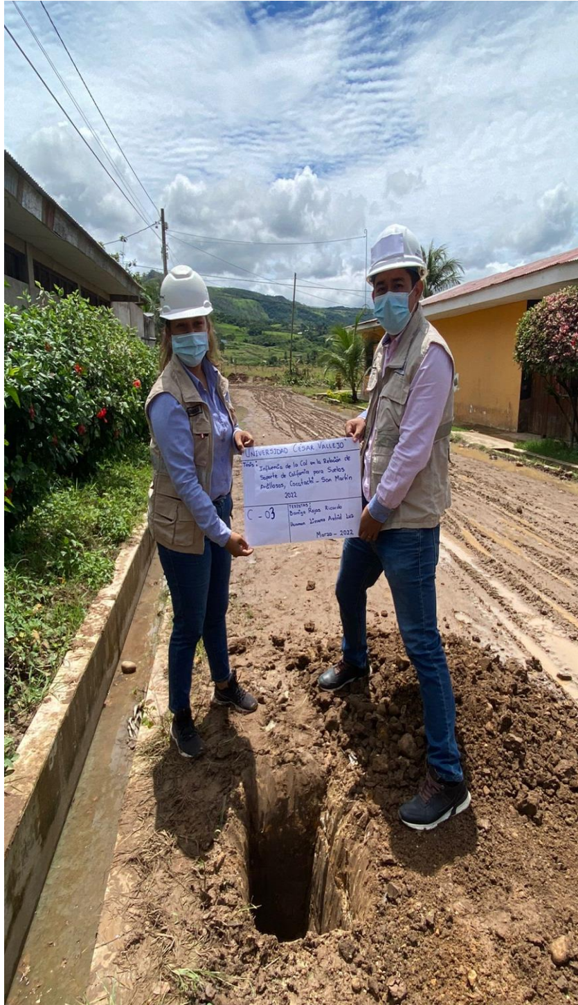
TOMA FOTOGRAFICA DE LA CALICATA N° 3
