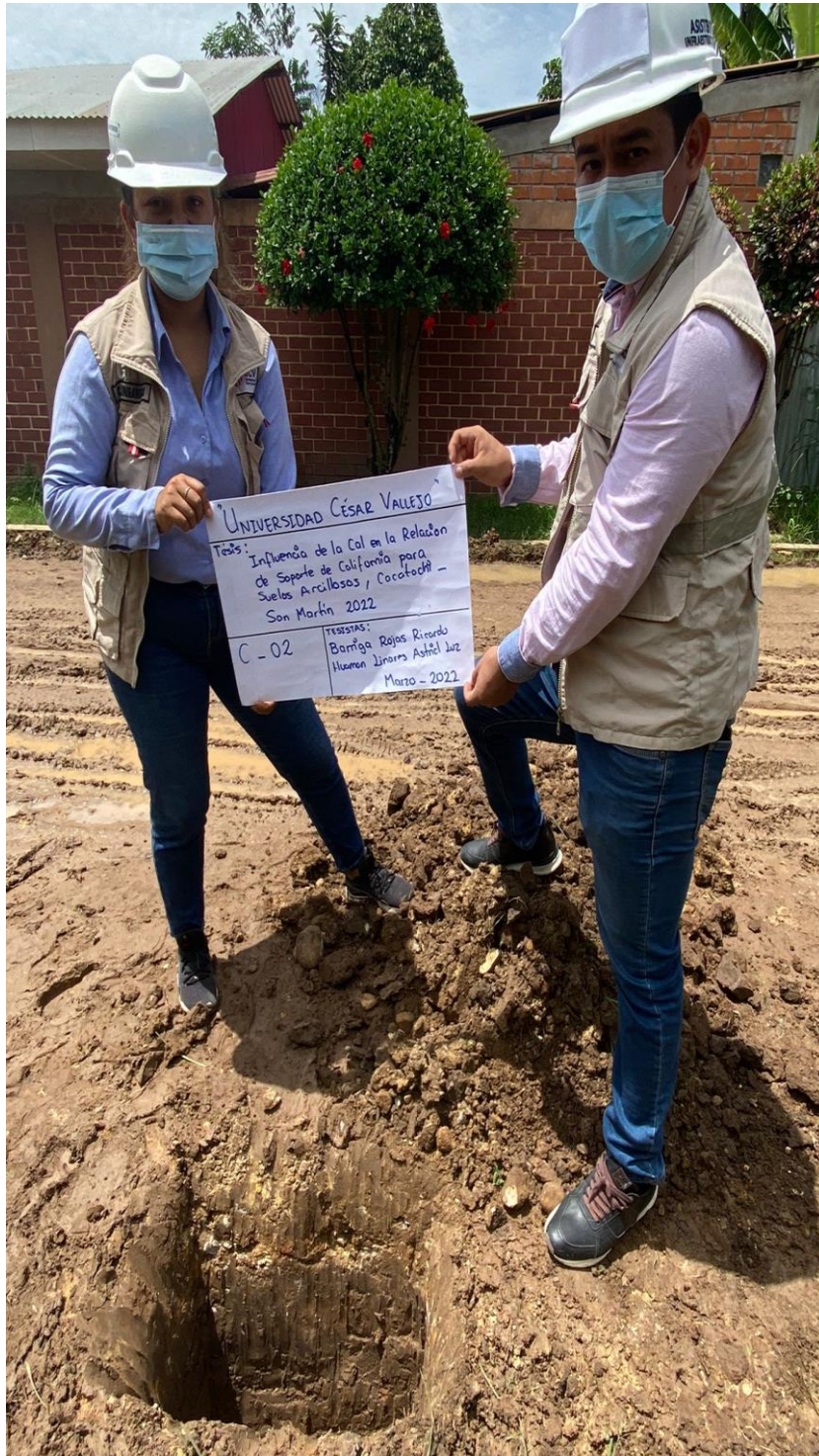
TOMA FOTOGRAFICA DE LA CALICATA N° 2
