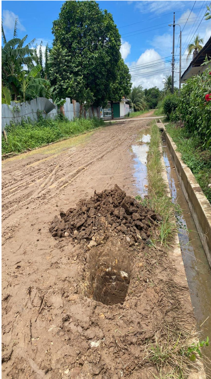
VISTA FOTOGRÁFICA DEL ESTADO DEL Jr. ADRIANA DELGADO. CALICATA N° 1
