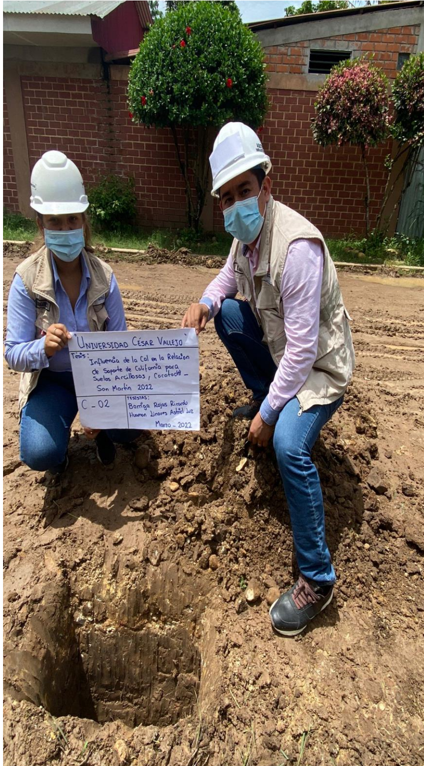
TOMA FOTOGRAFICA DE LA CALICATA N° 2
