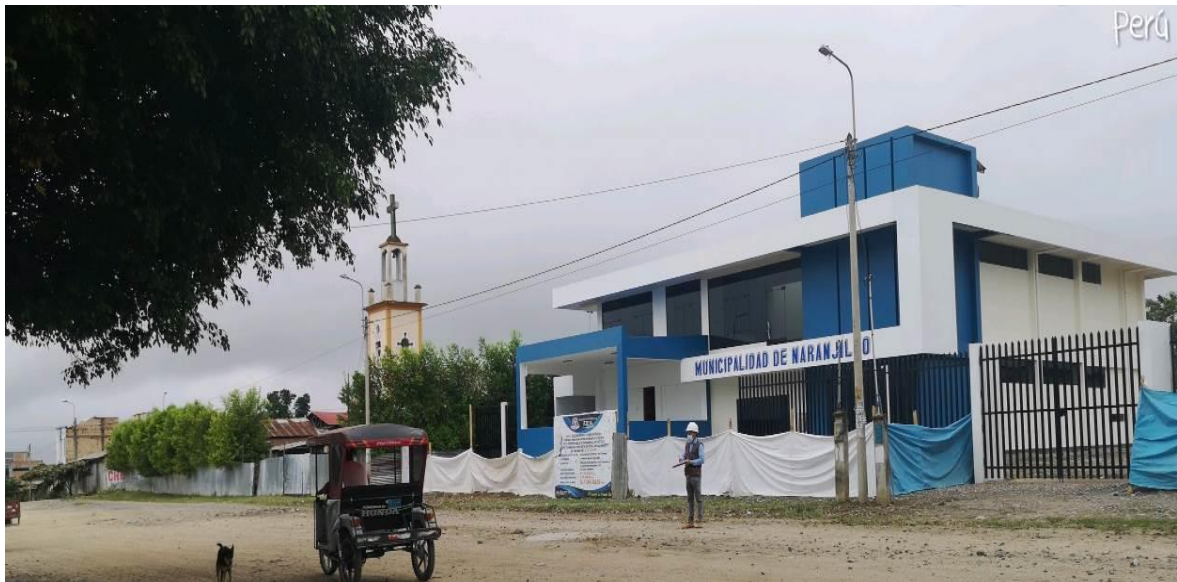
FOTO N°01: Se visualiza la infraestructura de la nueva edificación donde empezara a funcionar la municipalidad de Naranjillo.
