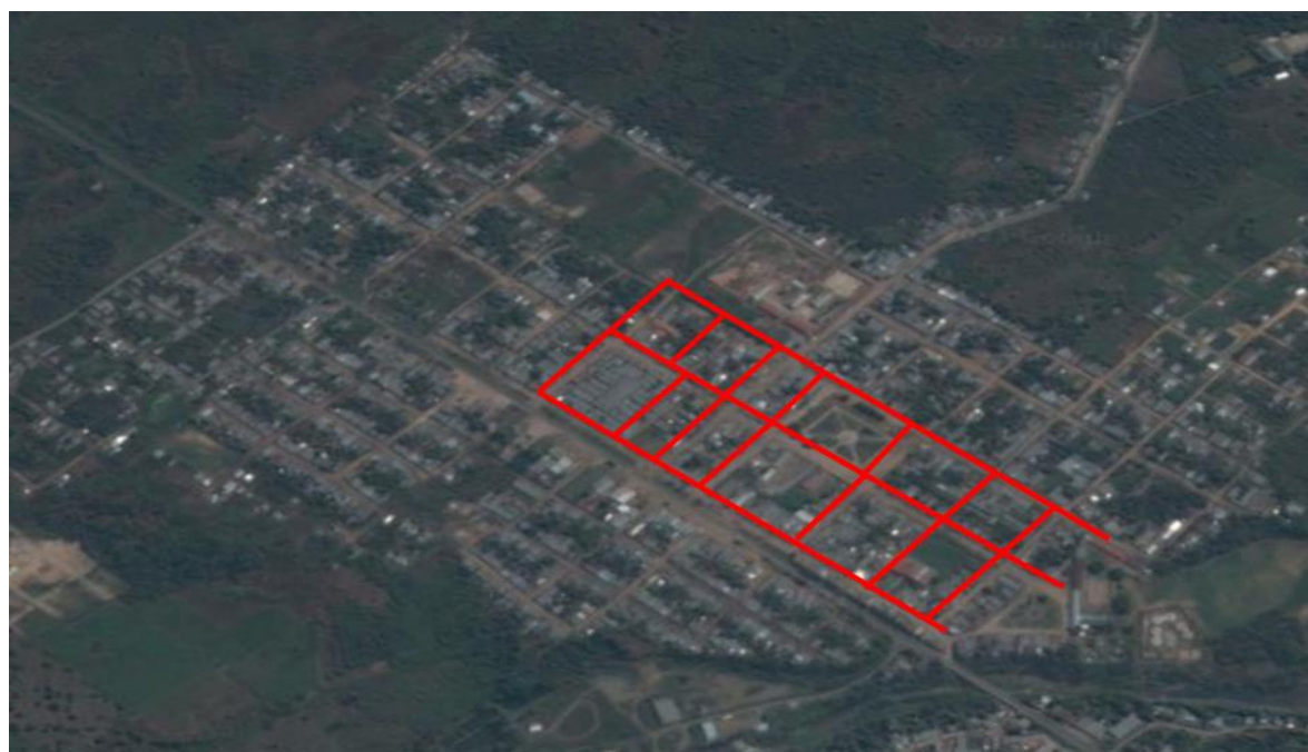
FOTO N°01: El proyecto se enmarca en el objetivo de realizar Diseño de infraestructura vial urbana margen derecho de la localidad Naranjillo - Nueva Cajamarca - Rioja - San Martín
