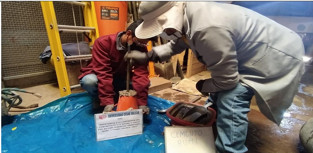
Fotografía N° 3: Varillado de probeta (Cemento rumi f'c 210kg/cm2).
