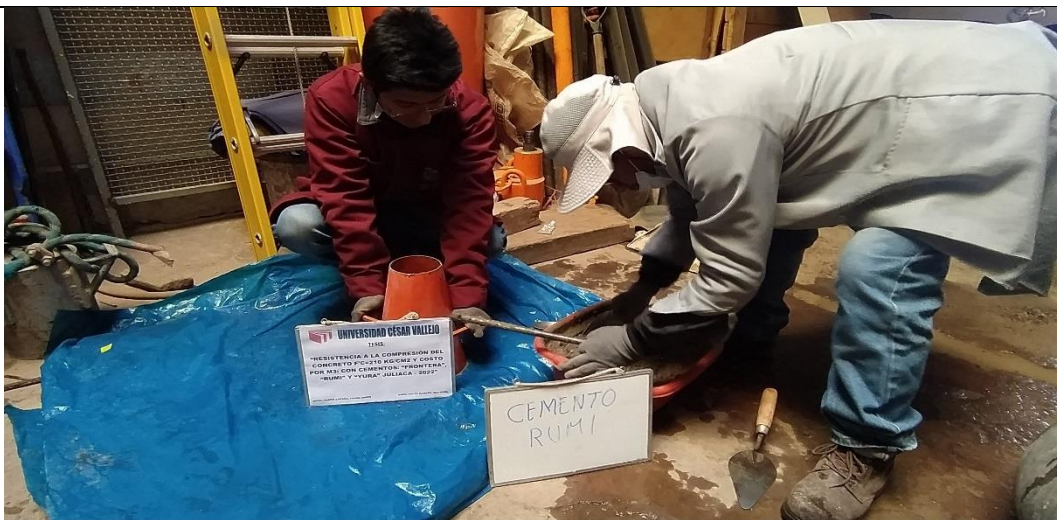
Fotografía N° 4: Colocado por capas de probeta de concreto.
