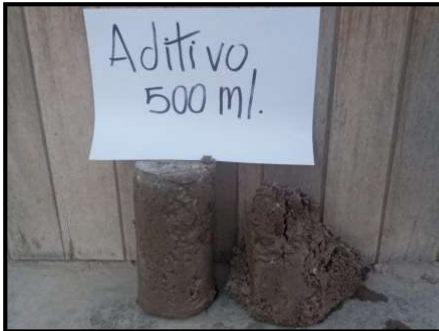
Figura 39. Consecuencias de la mala manipulación del aditivo en el concreto.
