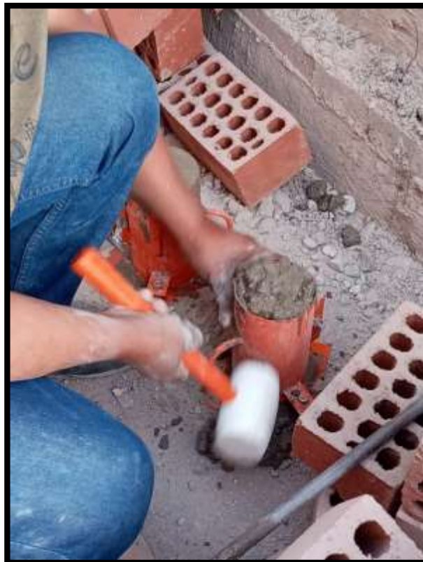
Figura 33. Llenado y compactado de la mezcla a los moldes.
