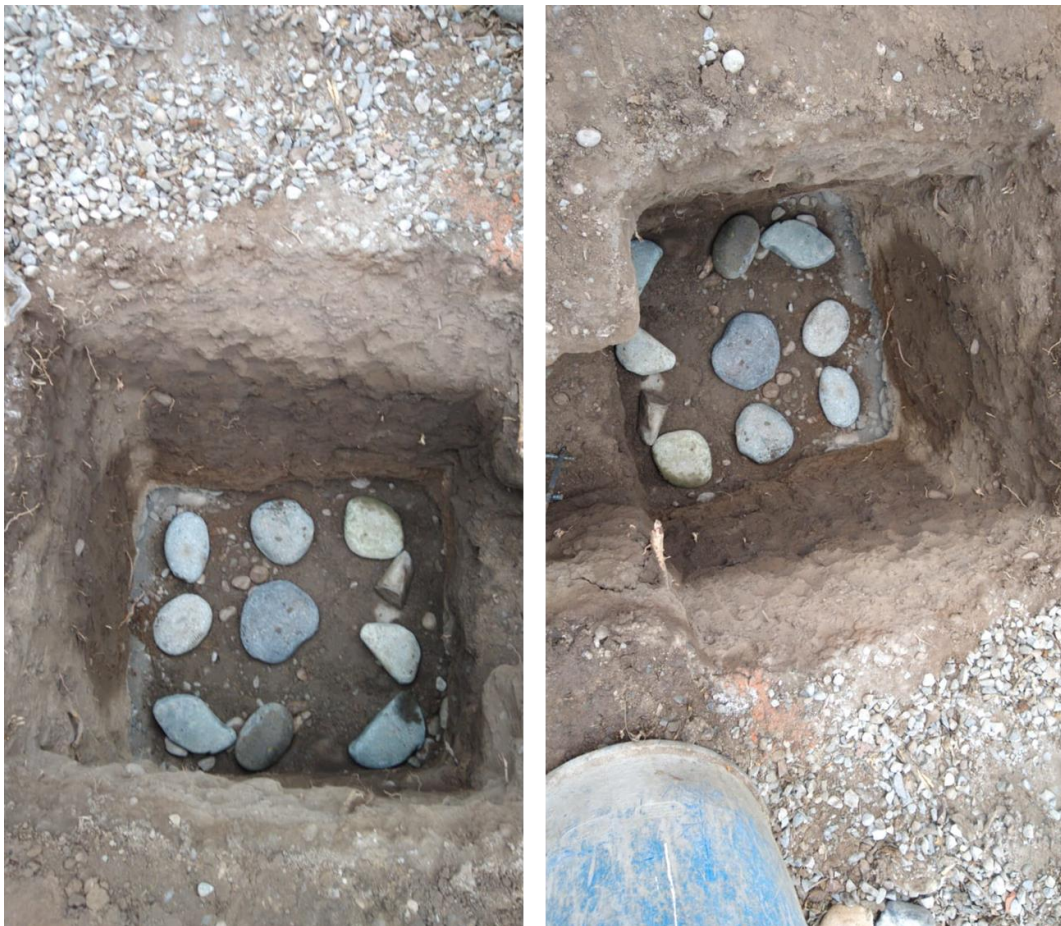
Imagen de la calicata
