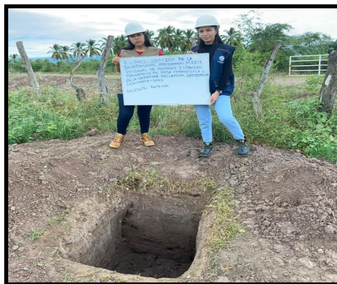
Figura 8. Excavación de la calicata C-02 carretera Bellavista – Sambimera
