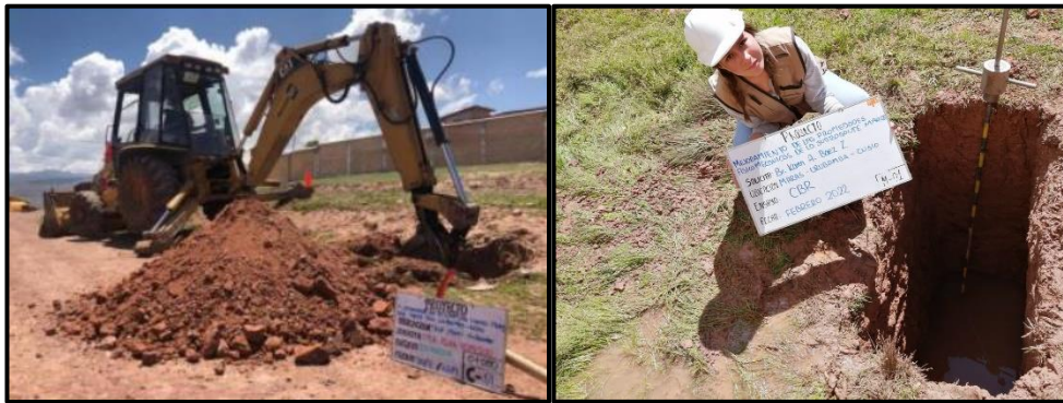
Figura 11 Extracción de calicatas
