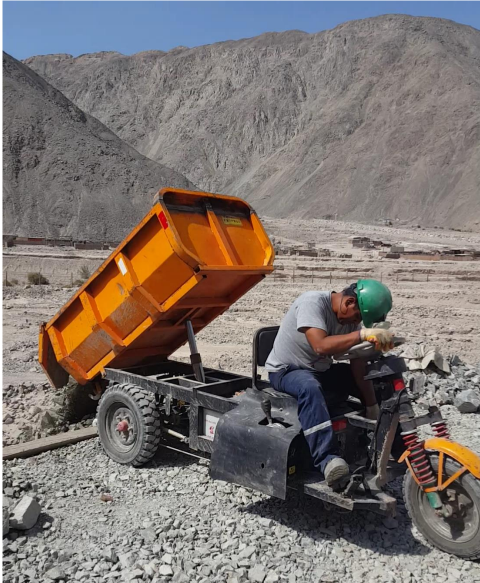
Descarga de desmonte con el Mini Dumper Eléctrico al depósito de desmonte.
