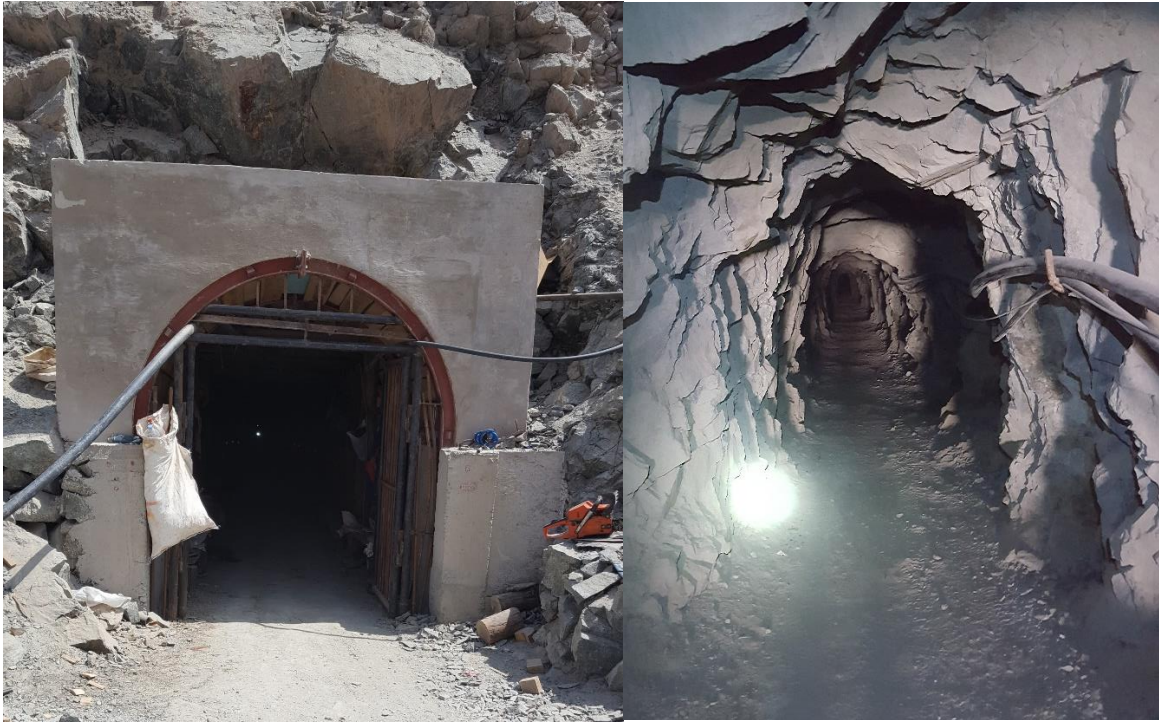
Cx. 1000 N – Nivel 740 del Proyecto Avispa y se puede visualizar que el tipo de roca es dura y por no tanto no se muestra sostenimiento.
