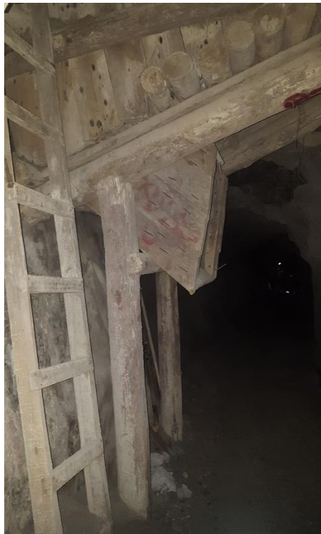
Buzón para el almacenamiento y descarga del material como el desmonte y mineral
