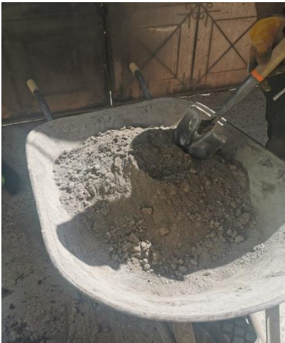
Figura 29. Agregado fino, grueso, cemento y microsílíce mezclados.
