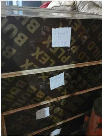
Figura 33. Vigas de concreto en molde.
