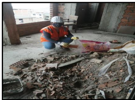
Figura 6. Recolección del ladrillo
