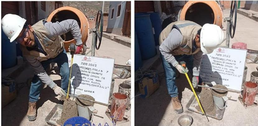
Fotografía 3 y Fotografía 4 Determinación del SLUMP.
