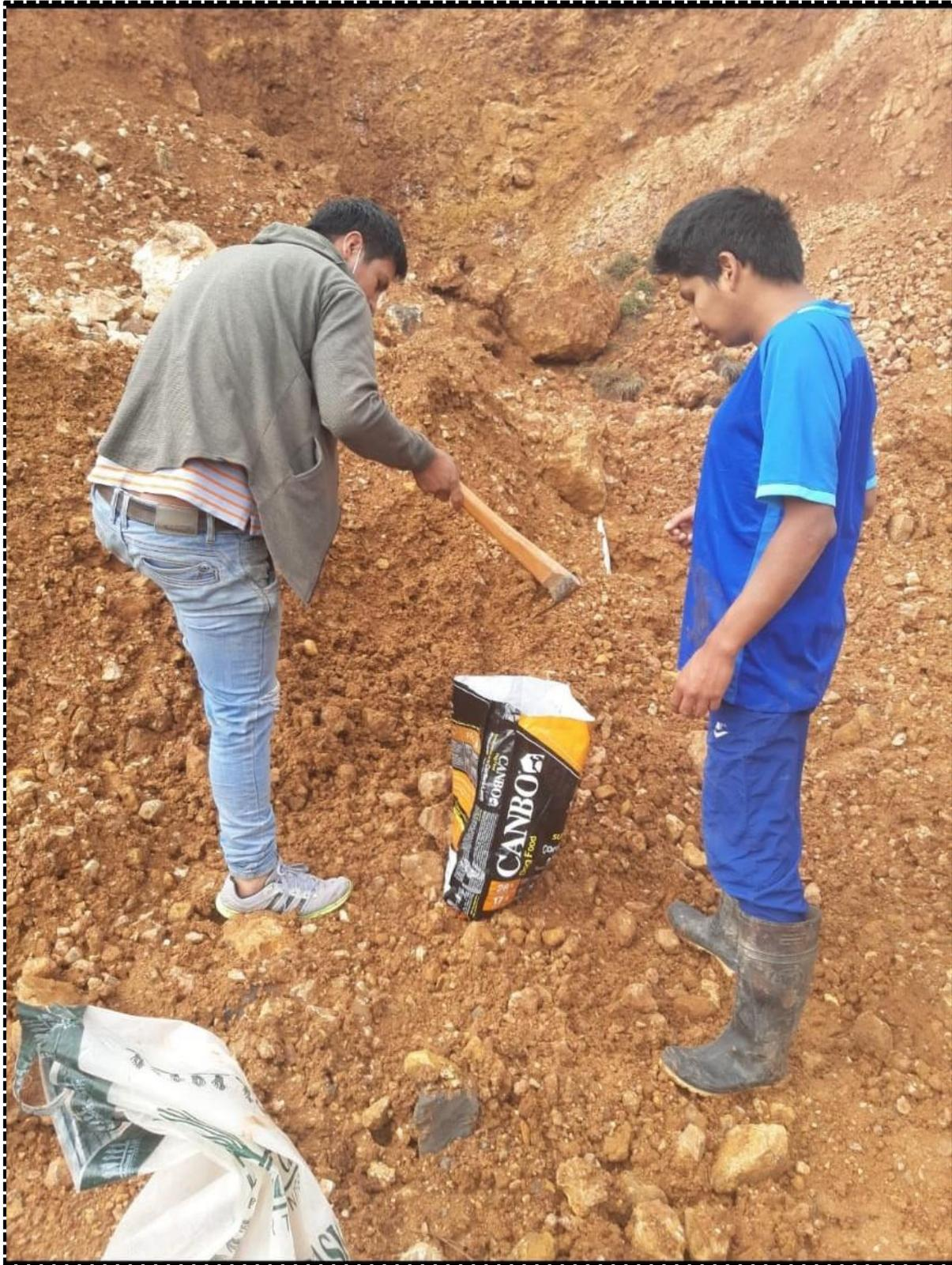
Fotografía 01: Extracción de la muestra en la Cantera Tucilla
