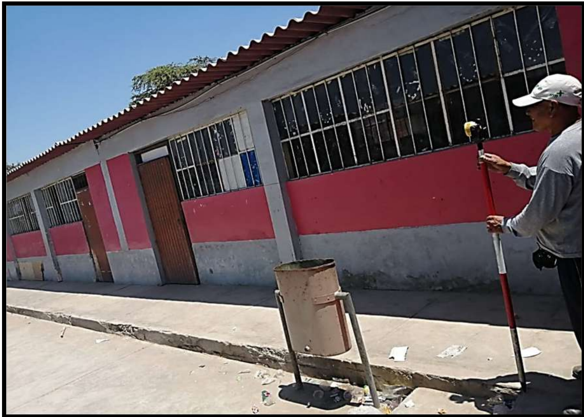
Foto N° 05. Personal radiando los puntos del terreno con estación total.
