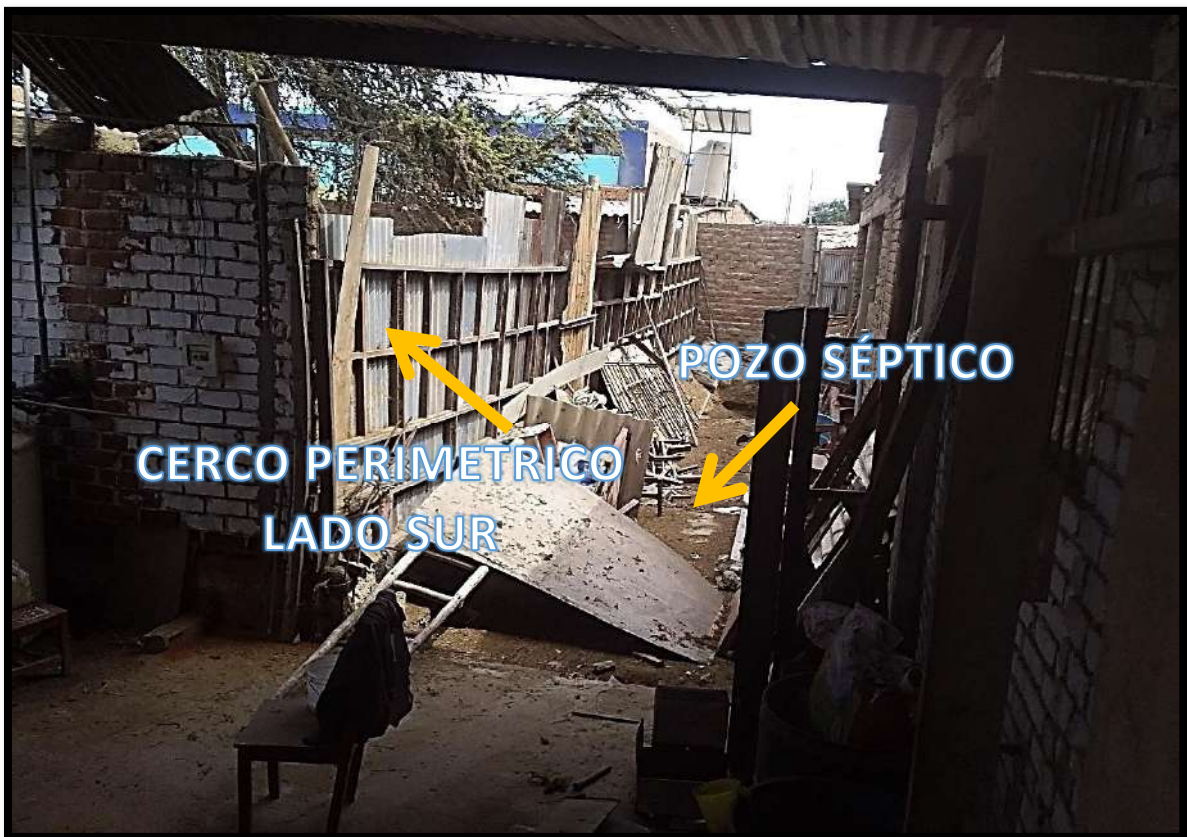
Foto N° 32. Cerco perimétrico (lado Sur), delimitado por un cerco construido con calaminas y estructuras de madera. Así mismo se muestra la ubicación del pozo séptico.
