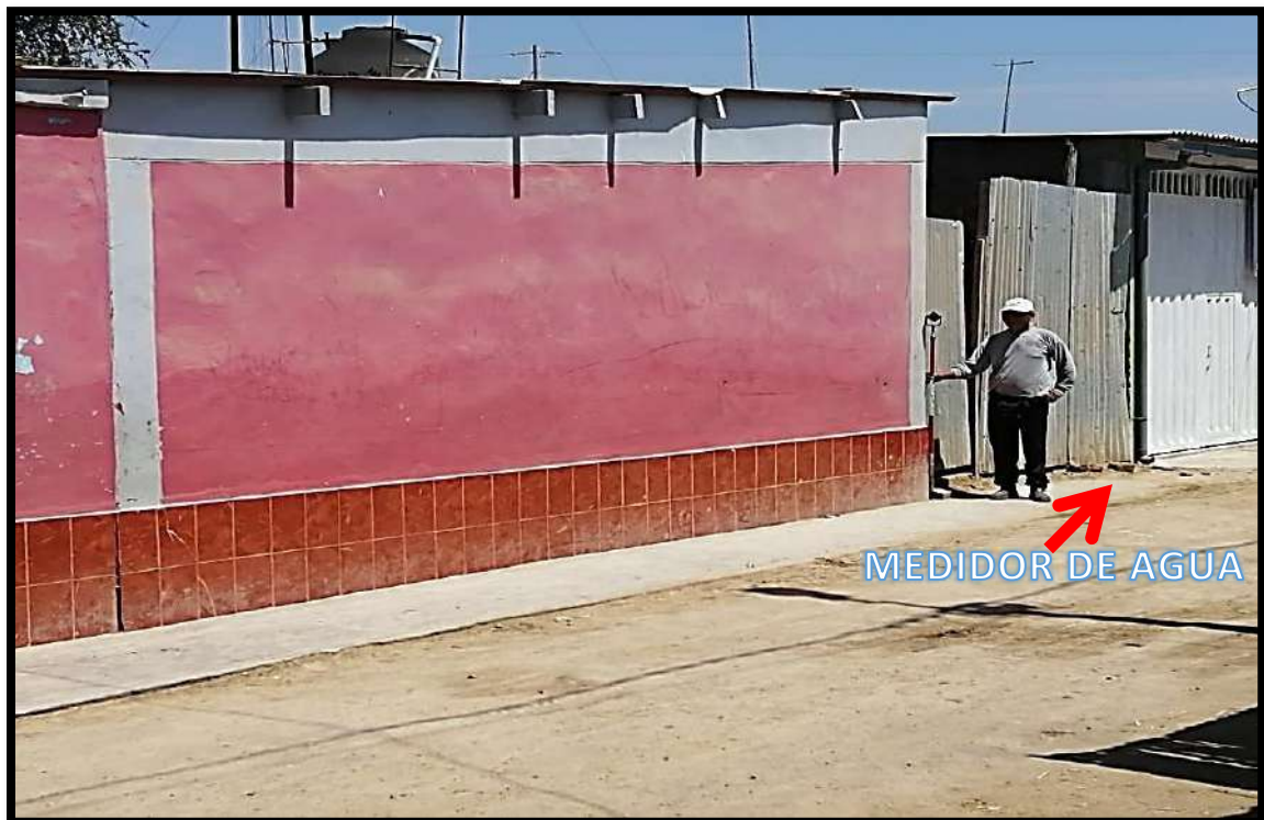
Foto N° 03. Auxiliar de Topografía con prisma, realizando trabajos en la parte exterior de la institución educativa. Se observa parte del frontis (lado Oeste) cercado con calaminas, además se indica la ubicación de la caja portamedidor de agua.
