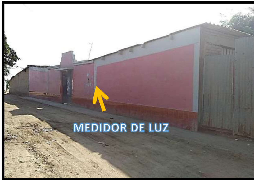
Foto N° 02. Frontis de la I.E. Primaria N° 10232. El acceso se vuelve difícil en tiempos de lluvia. Así mismo se indica la caja del medidor de luz.
