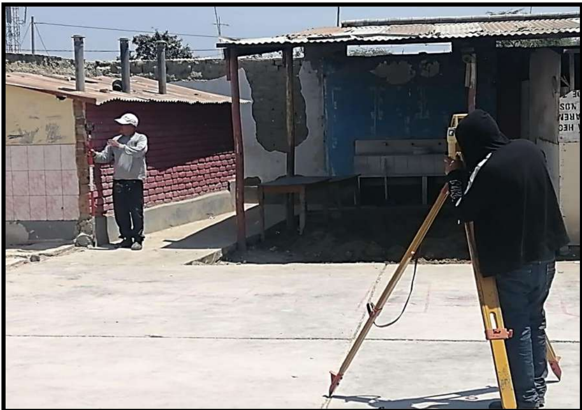
Foto N°04. Topógrafo realizando trabajos en la parte interna de la institución educativa.
