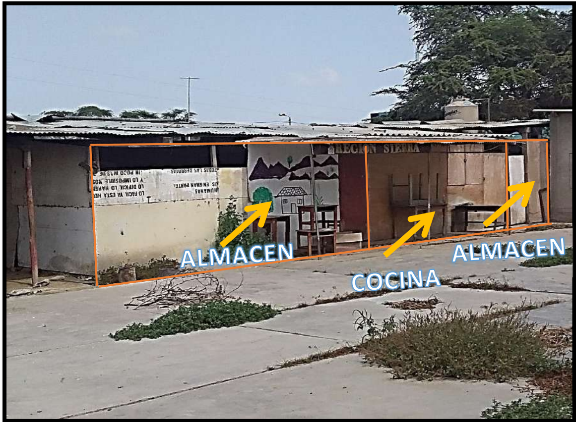
Foto N° 23. Parte externa de los almacenes y la cocina, contruidos con material prefabricado.
