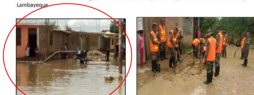
Trabajos de limpieza en los distritos de Túcume y distrito de Pacora
