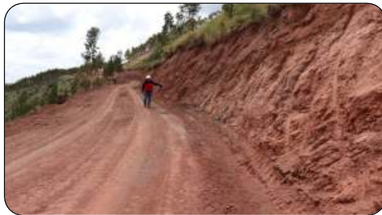
Figura 12. Identificación de taludes con sección crítica
