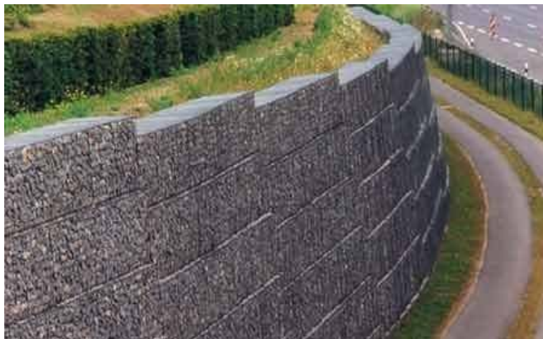
Figura 55: Muro de gaviones
