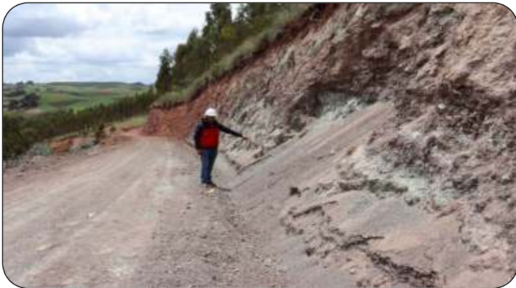
Figura 6. Identificación de carretera para levantamiento topográfico
