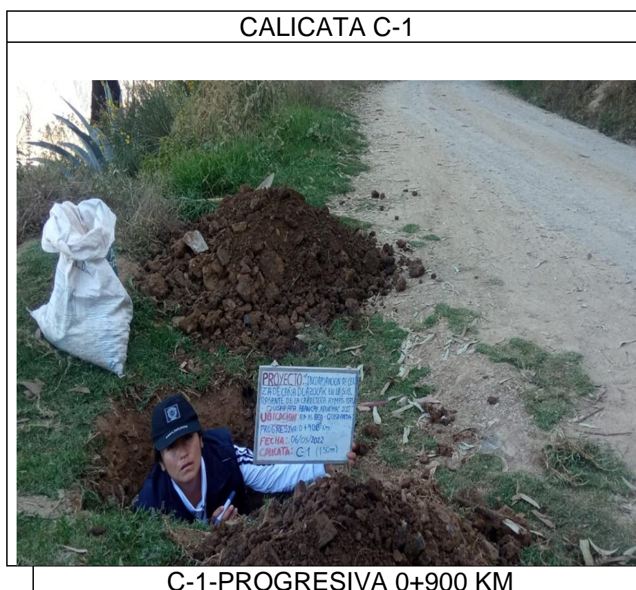
Figura 7. Calicatas en situ C-1, C-2, C-3, C-4 y C-5.
