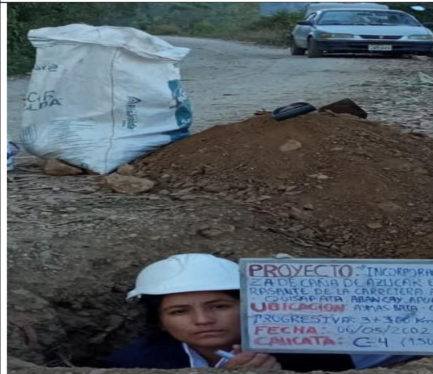
C-4 PROGRESIVA 3+300 KM
