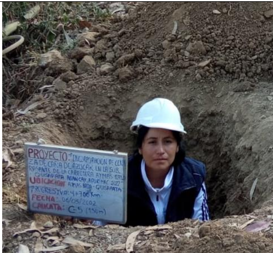
C-5 PROGRESIVA 4+700 KM
