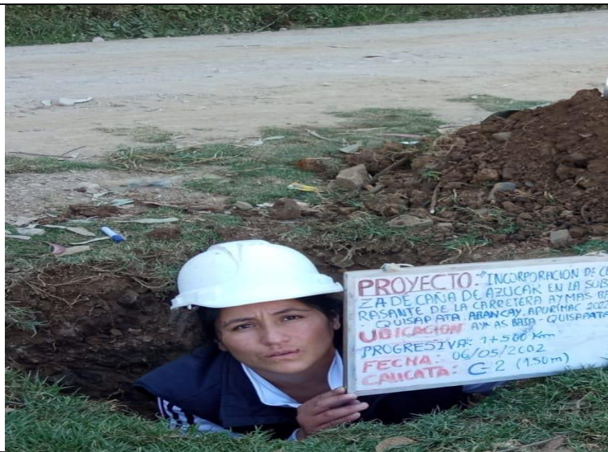
C-2 PROGRESIVA 1+500 KM
