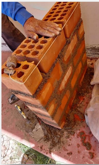
Figura 30.- culminando la elaboración de murete
