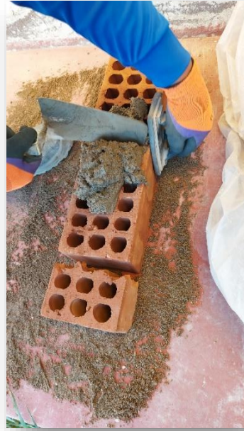
Figura 29.- Iniciando con asentado de ladrillos para el murete de albañilería
