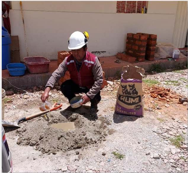
Figura 26.- Elaborando la mezcla de mortero con dosificación de Ms y Ns
