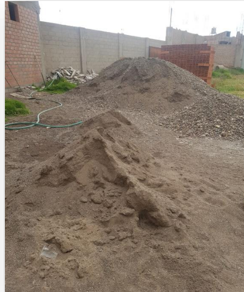
Figura 19.- Acopio de Arena Gruesa para inicio de elaboración de mortero
