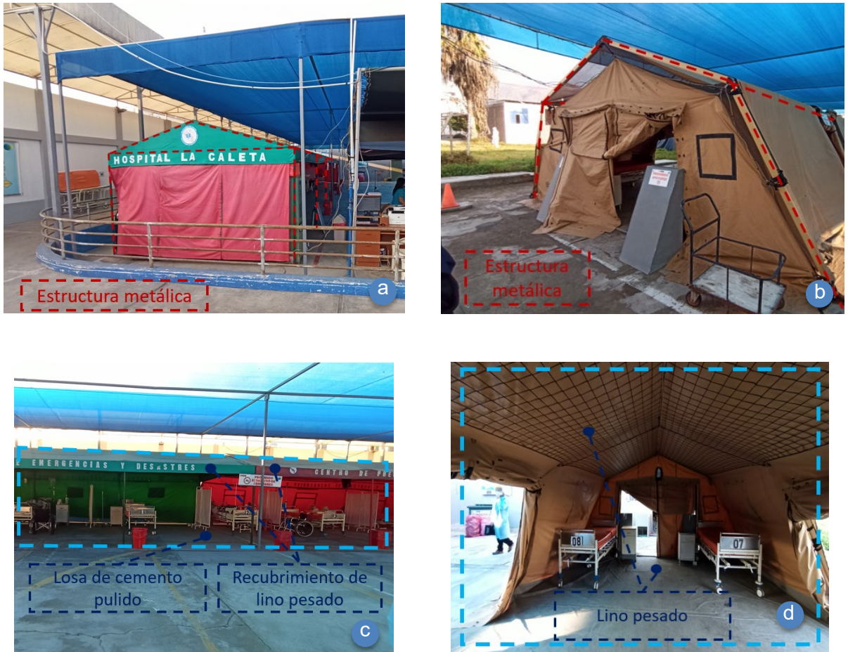
Figura 14, Materiales estructurales y no estructurales de los ambientes de tratamiento Covid
