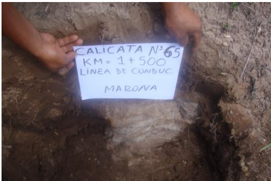
Se observa la calicata N° 65 Línea de Conducción.
