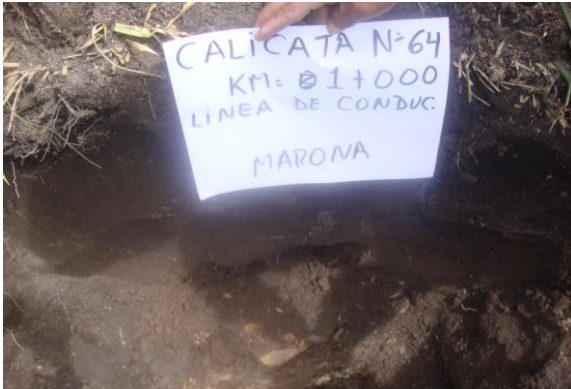
Se observa la calicata N° 64 Línea de Conducción.
