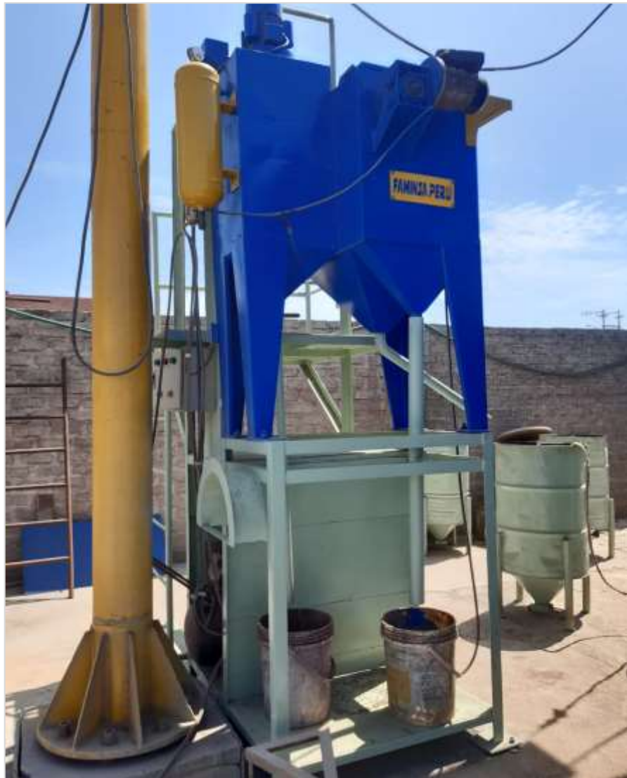
Figura 20. Ejecución de actividades de mantenimiento planificado
