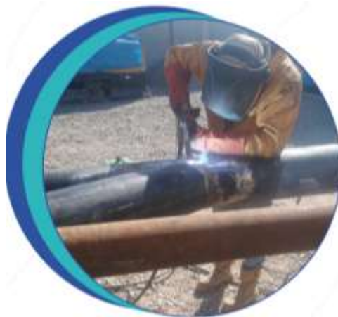
Figura 6. Soldeo de estructuras
