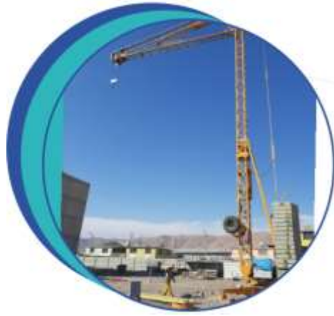
Figura 7. Reparación de grúa torre
