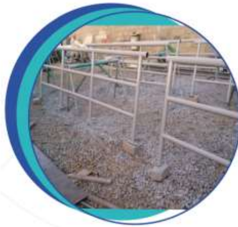
Figura 2. Fabricación de barandas
