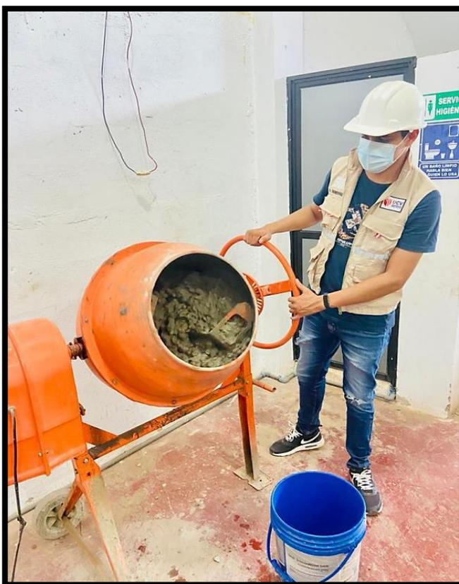
**Anexo 43:** Panel Fotográfico N° 14 – Inclusión de las fibras de cepa de plátano para la elaboración del concreto  $f'c=210$  kg/cm<sup>2</sup>.
