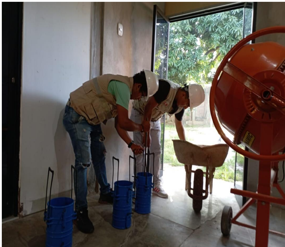
Foto N°12: Chuseado con la varilla de acero.
