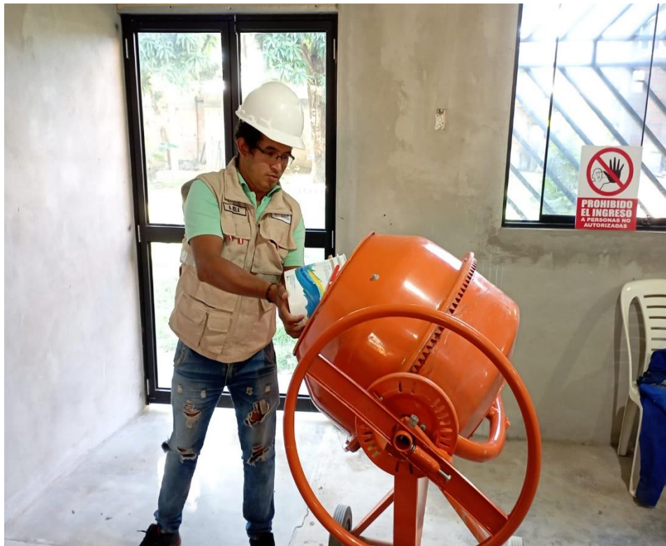
Foto N°11: Mezclado de componentes del concreto.
