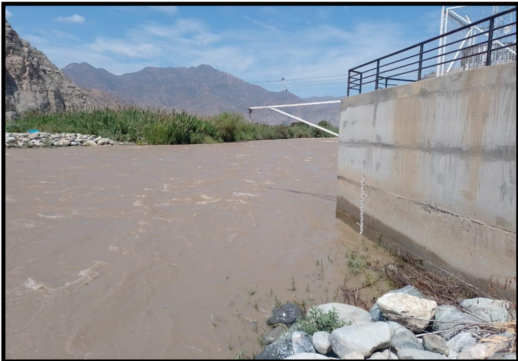
Fotografía N° 2: Vista del instrumento de la medición hidrométrica
