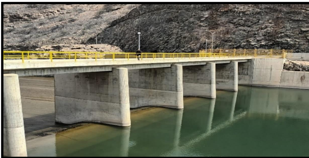
Fotografía N° 9: Inicio del aliviadero con vista a las crestas anchas
