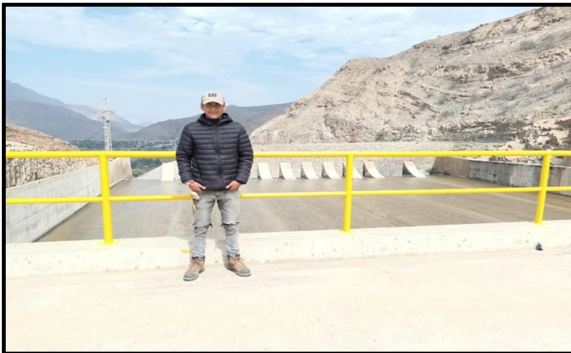
Fotografía N° 3: Vista de los dado disipadores del aliviadero de masías
