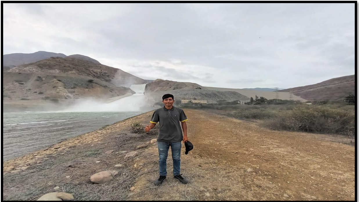
Fotografía N° 12: Vista del aliviadero y el cuerpo de la represa.
