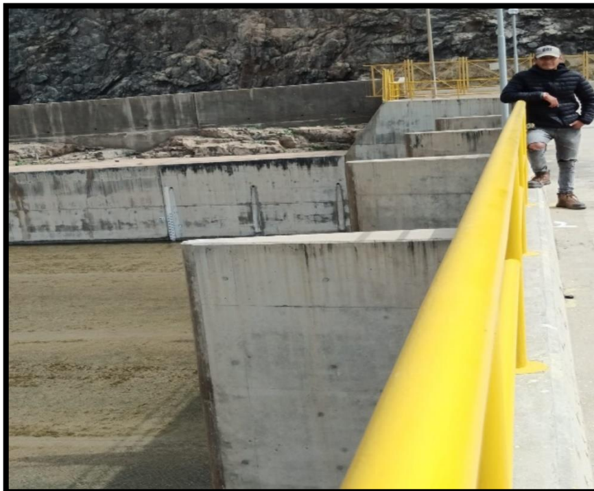
Fotografía N° 6: Aliviadero de masías
