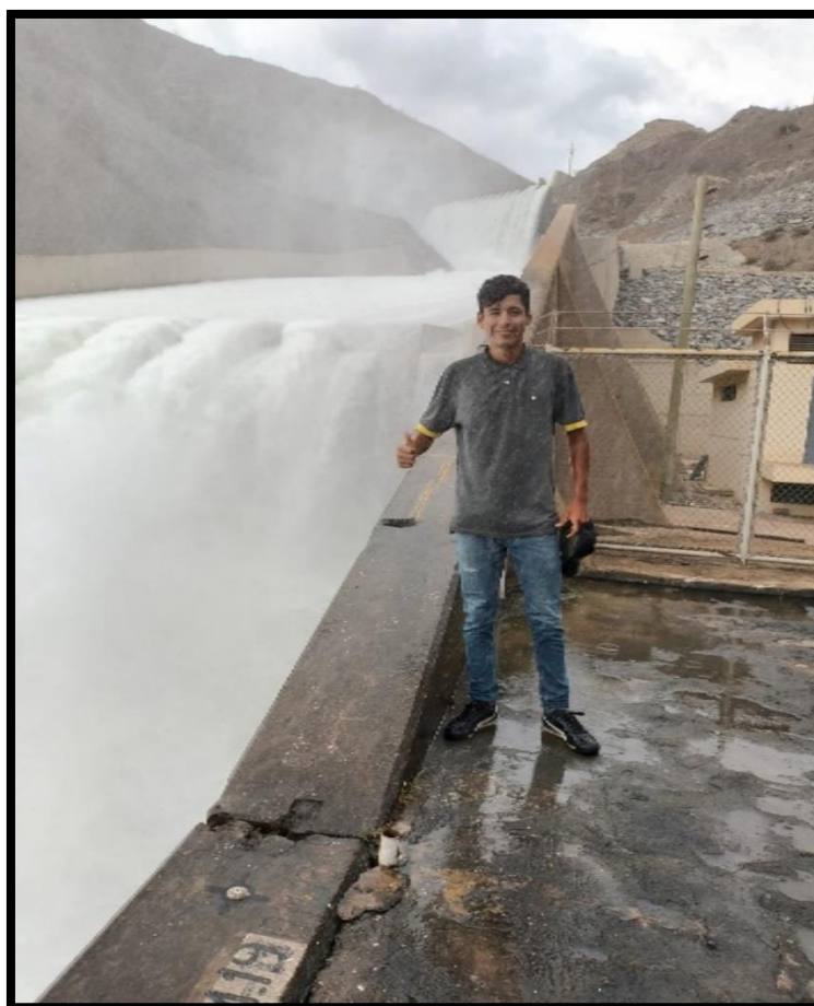
Fotografía N° 10: Rápida en funcionamiento
