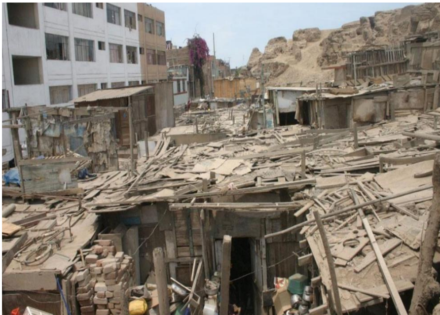
Figura 13: Invasión de viviendas precarias en la Huaca Huantille (antes de su intervención)
