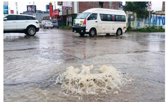
Colapso de buzones de desagüe a falta de un drenaje pluvial.
