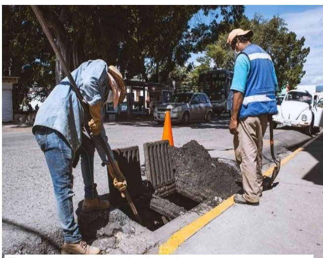
Figura 16. Limpieza de drenajes Fuente: elaboración propia Yordy Dueñas C. (2021)
