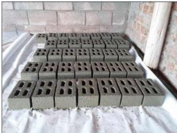
Reposo y curado de los ladrillos de prueba.
