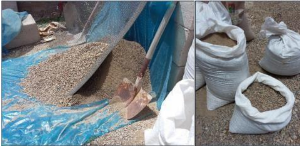
Preparación de los agregados
