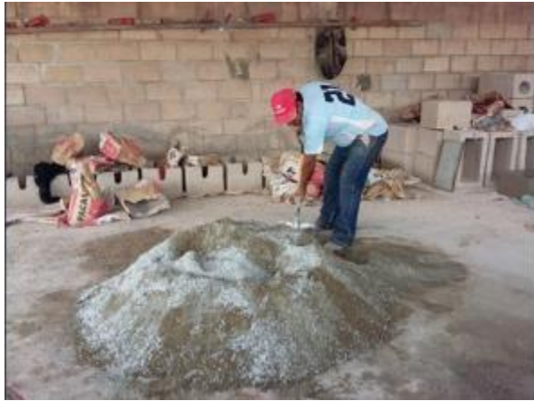
Mezclado de los agregados
