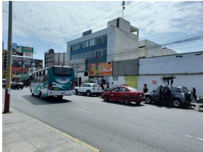
Figura 03. Contorno Urbano, Avenida José Pardo.
