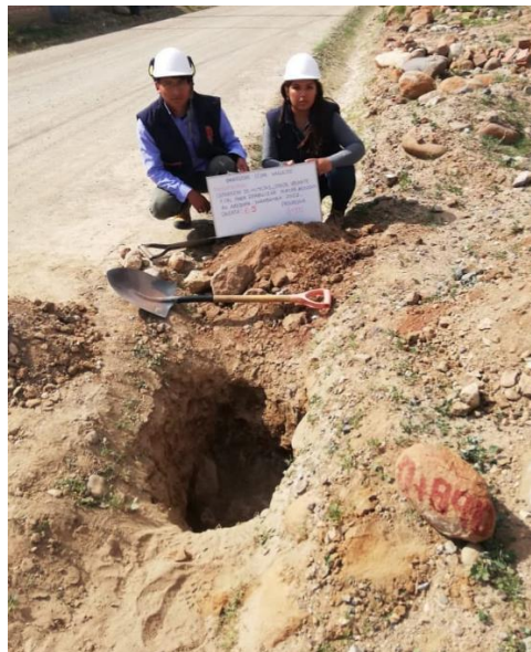
Figura 9: Extracción de material - Calicata N°5
