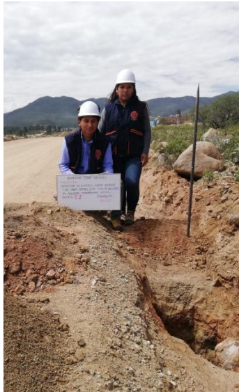
Figura 6: Extracción de material - Calicata N°2
