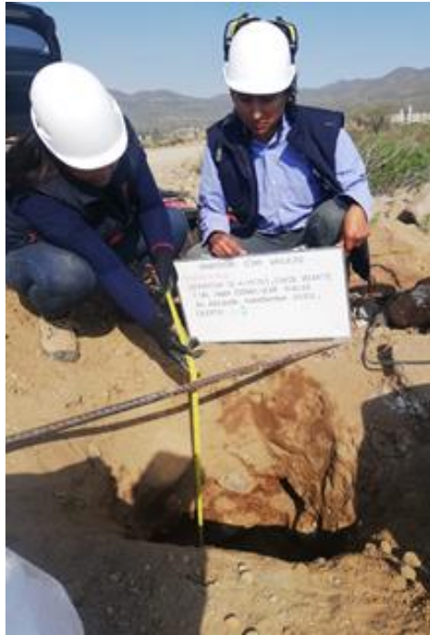
Figura 8: Extracción de material - Calicata N°4
