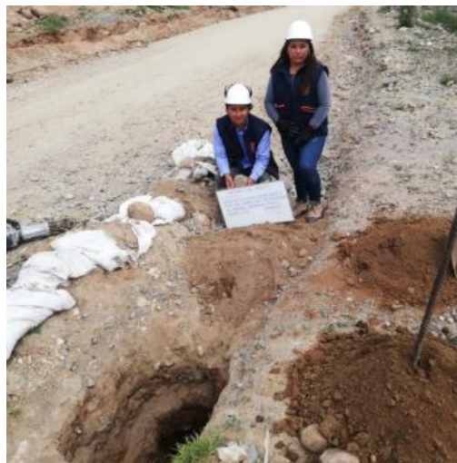
Figura 5: Extracción de material - Calicata N°1
