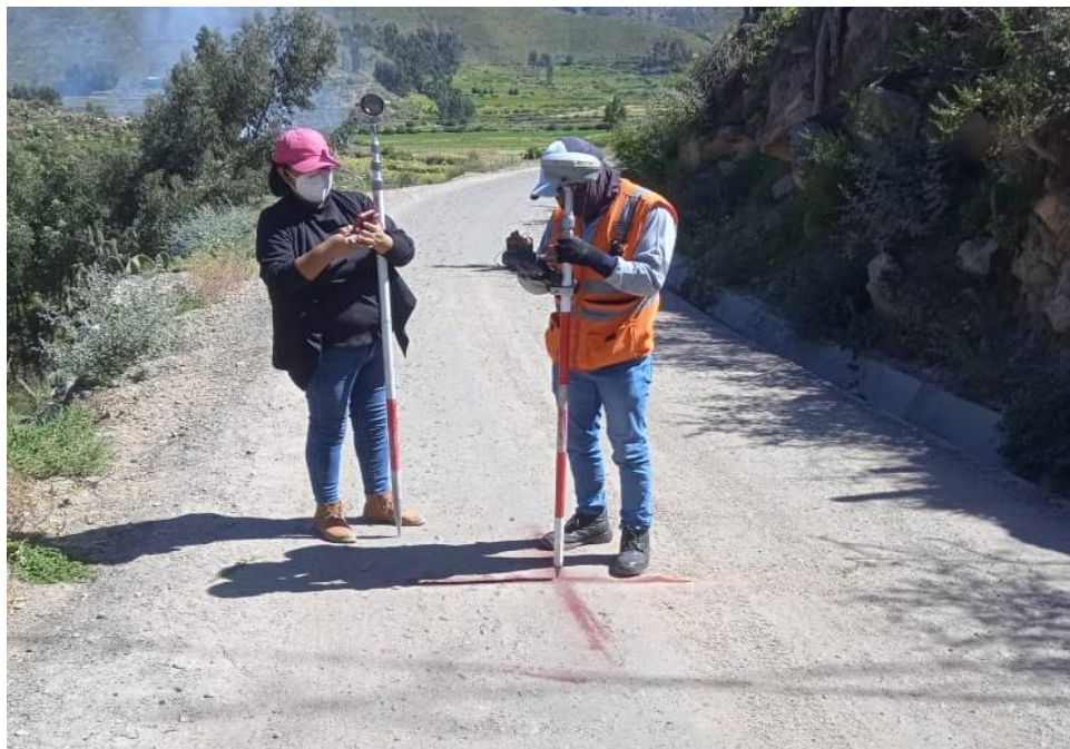
Figura 13. Levantamiento topografico con ROVER de BM a nivel de eje de vía
