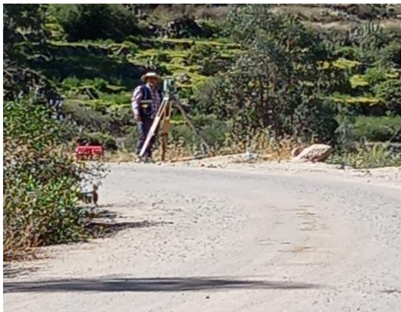
Figura 15. Levantamiento con Estación Total de eje de vía.
