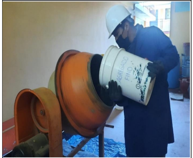
Fotografía N°26: Preparación del concreto en mezcladora tipo trompo
