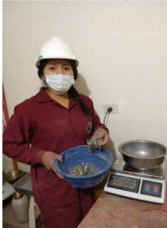
Figura 18. Fibras de aluminio, listos para realizar el peso y adiconar al concreto
