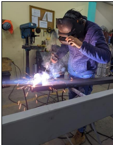
Figura N° 11: Trabajador realizando una soldadura sin sus guantes de seguridad
