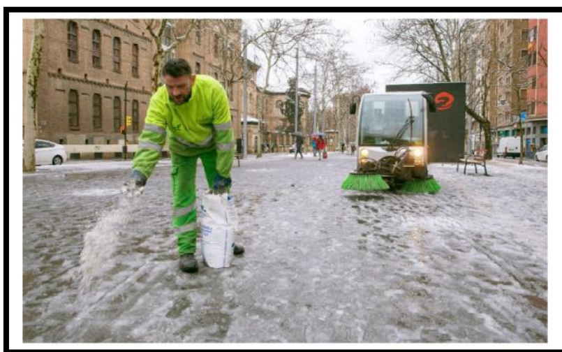
Figura 5. Uso de Cloruro de magnesio en carreteras. Fuente elaboración propia
