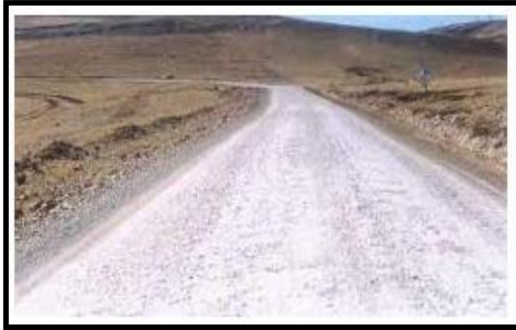
Figura 7. Uso de cloruro de sodio en subrasante. Repositorio UPC
