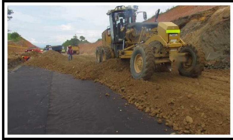
Figura 12. Estabilización de subrasante. Florencia-Puerto rico 2016
