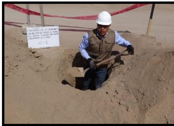
Figura 37. Inicio de excavación calicata C-01
