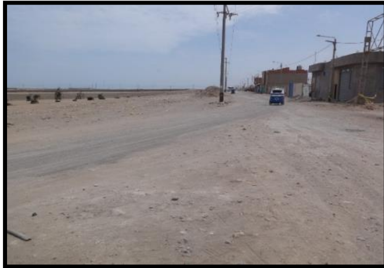
Figura 27. Subrasante AA.HH. Santa rosa. Elaboración propia
