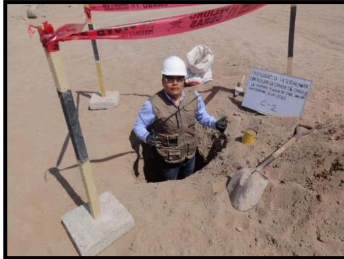
Figura 39. Excavación Calicata C-02
