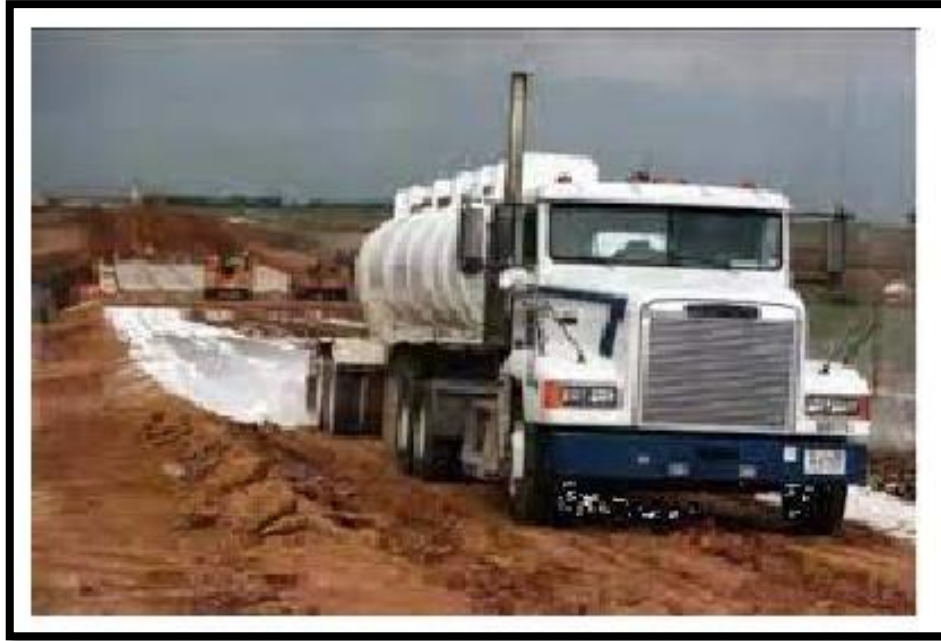
Figura 8. Estabilización química de suelos. Google
