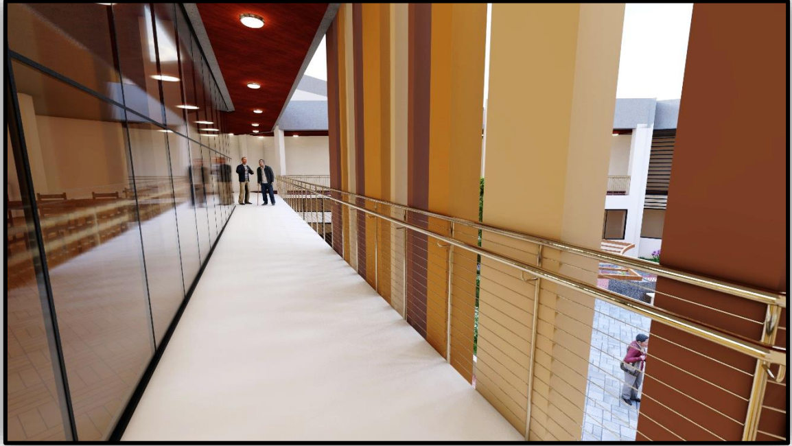
Vista 09: vista de corredor del segundo nivel de la zona de entretenimiento, se observa la barandilla con su respectivo pasamano e iluminación.
