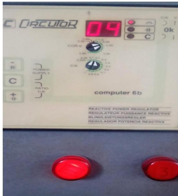
Figura A7.1. Regulador de potencia reactiva
