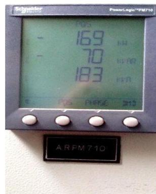
FiguraN°2.2 Se muestra el analizador de redes PM710 MG CA.
