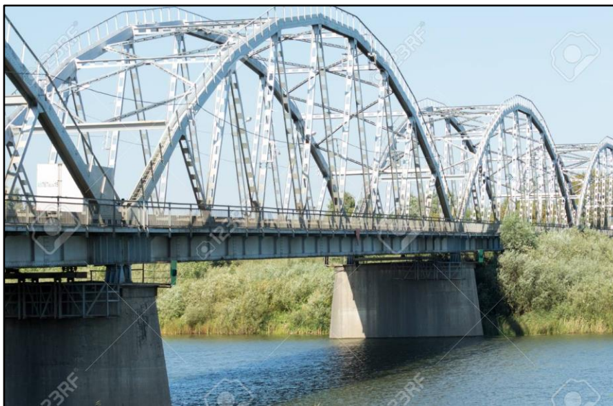
Figura 4. Puente estructura metálica
