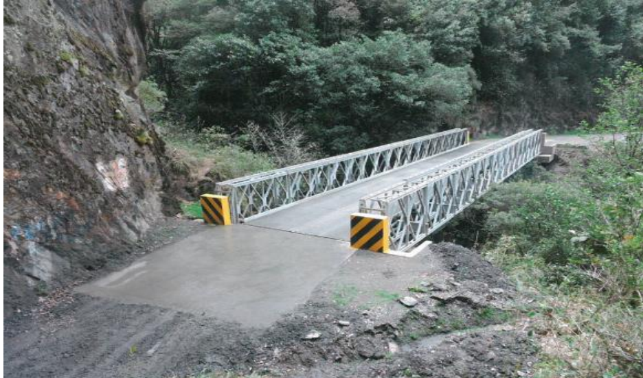
Figura 5. Puente Modular prefabricado
