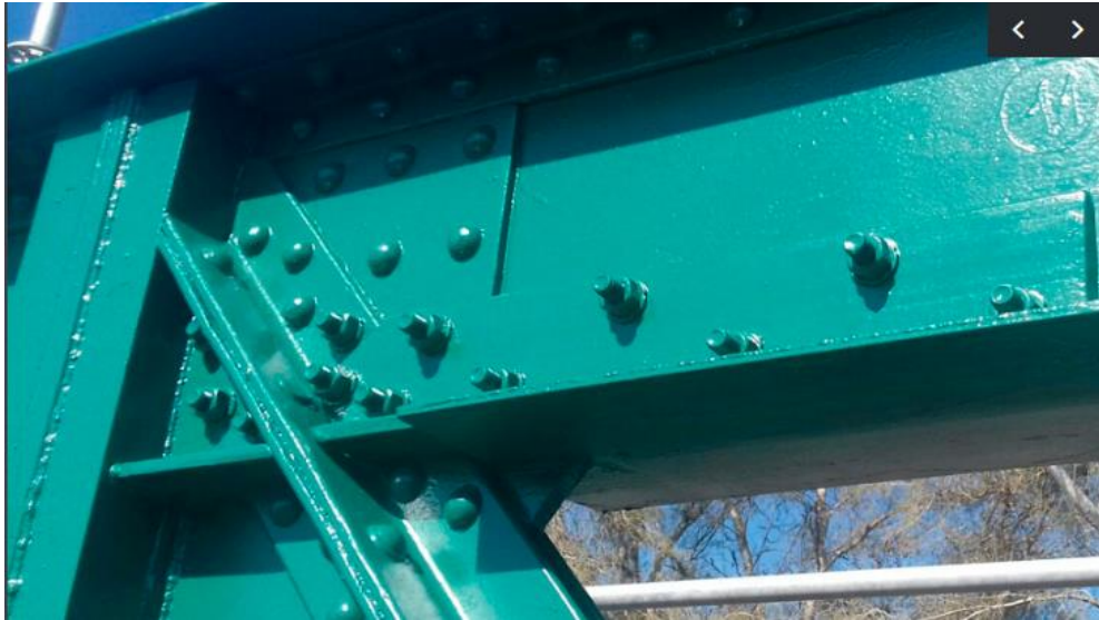
Figura 6. Pernos en la estructura metálica
