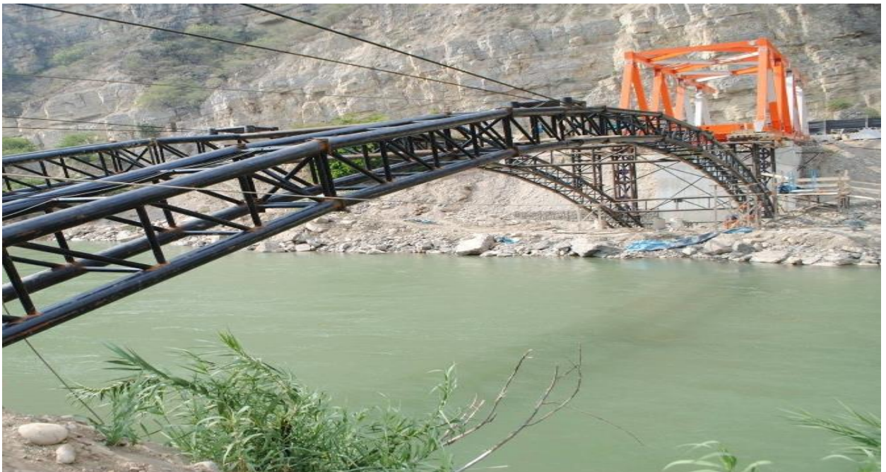
Figura 16: Lanzamiento de estructura del puente
