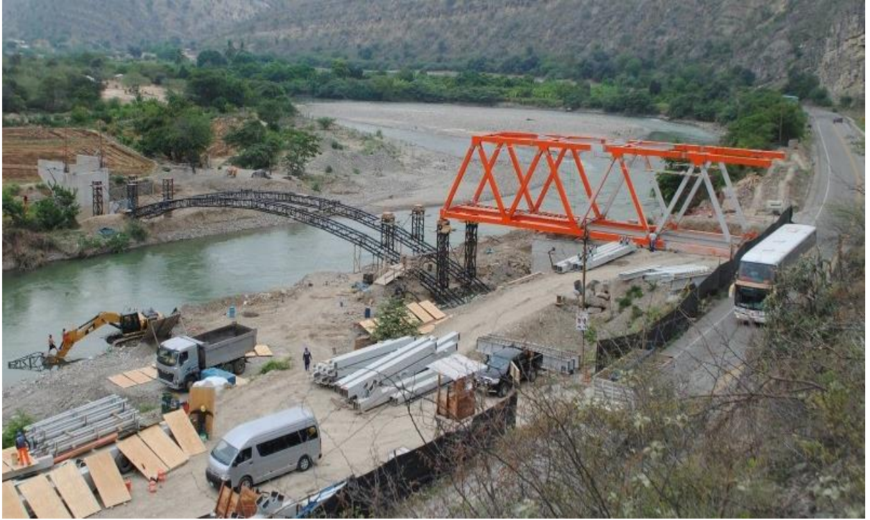
Figura 15: Armadura de estructuras del puente
